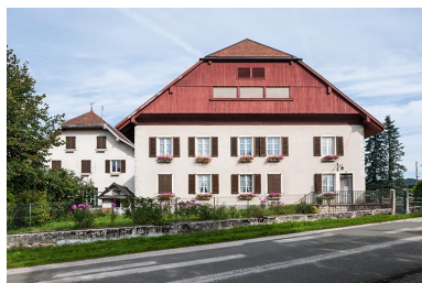
Façade sud de bâtiment (côté logement). Phot. Jérôme Mongreville IVR43_20142501244NUC4A
