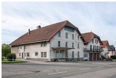
Vue de trois quarts depuis le nord. Phot. Jérôme Mongreville IVR43_20142501242NUC4A
