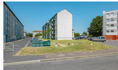
Bâtiment SIDEN, façades postérieure ouest et latérale sud. Phot. Thierry Kuntz IVR26_20155800070NUC4A
