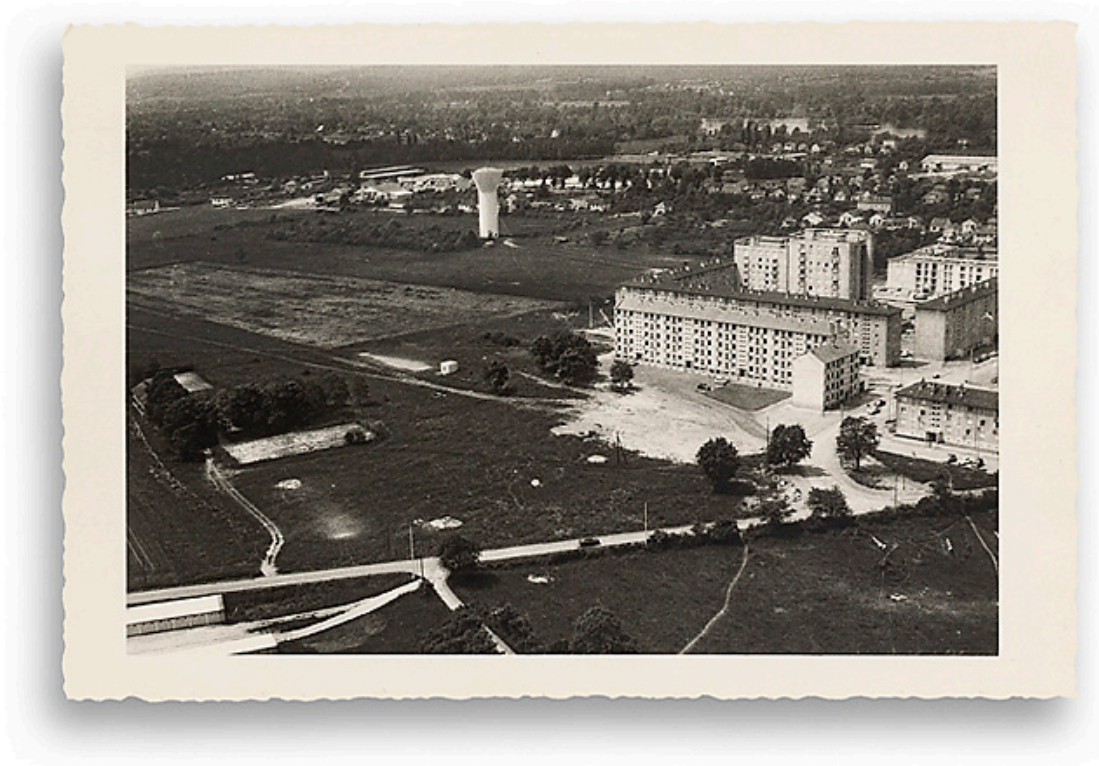
Vue aérienne du quartier Saint-Laurent en construction. Photographie ancienne, s.d., [1970-1971]. (Archives municipales Cosne-Cours-sur-Loire, 202W683 - 2Fi79)
