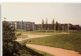
Aménagement du parc Schweitzer, à l'arrière-plan les immeubles 26 et Binot-E. Photographie ancienne, 1982. (Archives municipales Cosne-Cours-sur-Loire, 202W683 - 2Fi53) Phot. IVR26_20145800112NUC2A
