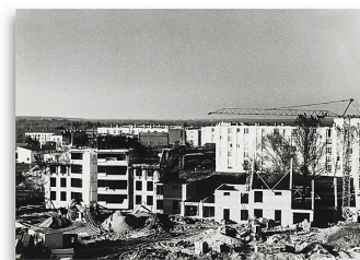
Construction des immeubles du programme Les Hauts de Loire. Photographie ancienne, ca. novembre 1981. (Archives municipales Cosne-Cours-sur-Loire, 202W683 - 2Fi182) Phot. IVR26_20145800128NUC2A
