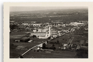
Vue aérienne du quartier Saint-Laurent en construction. Photographie ancienne, s.d., [1970-1971].
