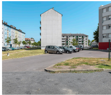
Bâtiment SIDEN, façade latérale sud et façade postérieure sud. Phot. Thierry Kuntz IVR26_20155800074NUC4A
