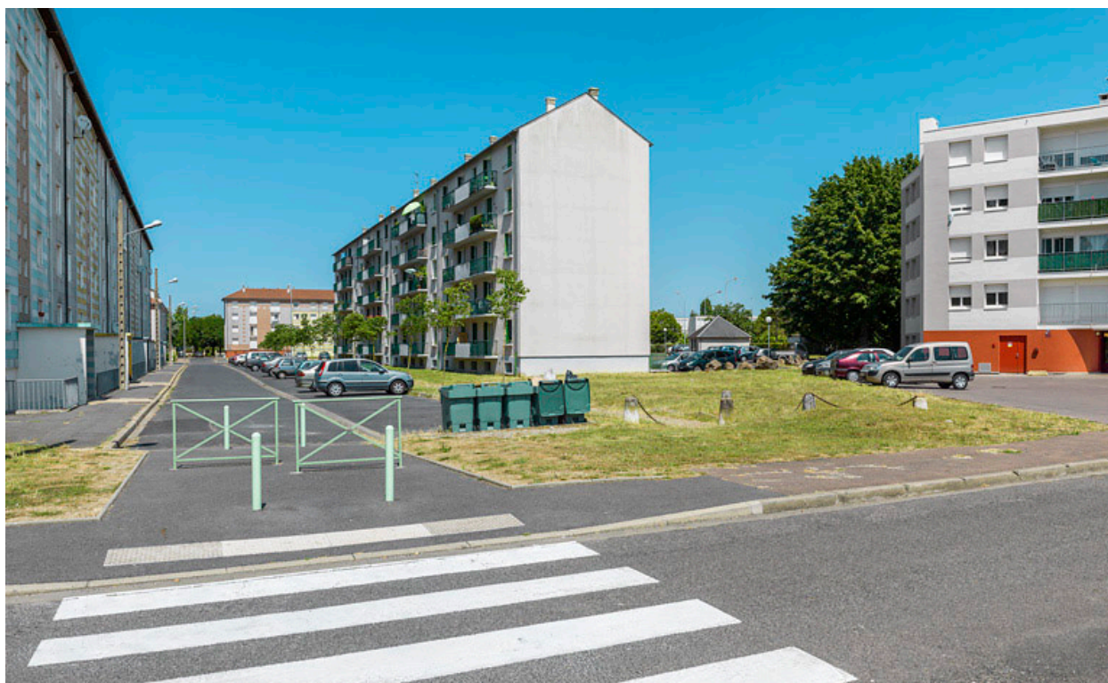
Vue générale depuis la place Pierre et Marie Curie en direction du nord.
