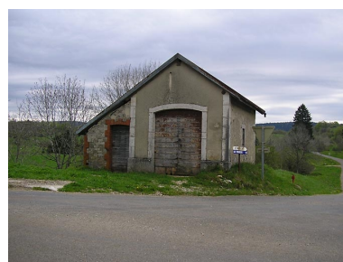
La remise de matériel d'incendie. Phot. Marie-Pierre Reynet IVR43_20083900425NUC1A
