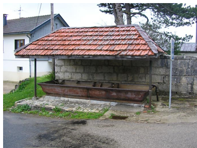
Abreuvoir situé rue Le Clos. Phot. Marie-Pierre Reynet IVR43_20083900381NUC1A
