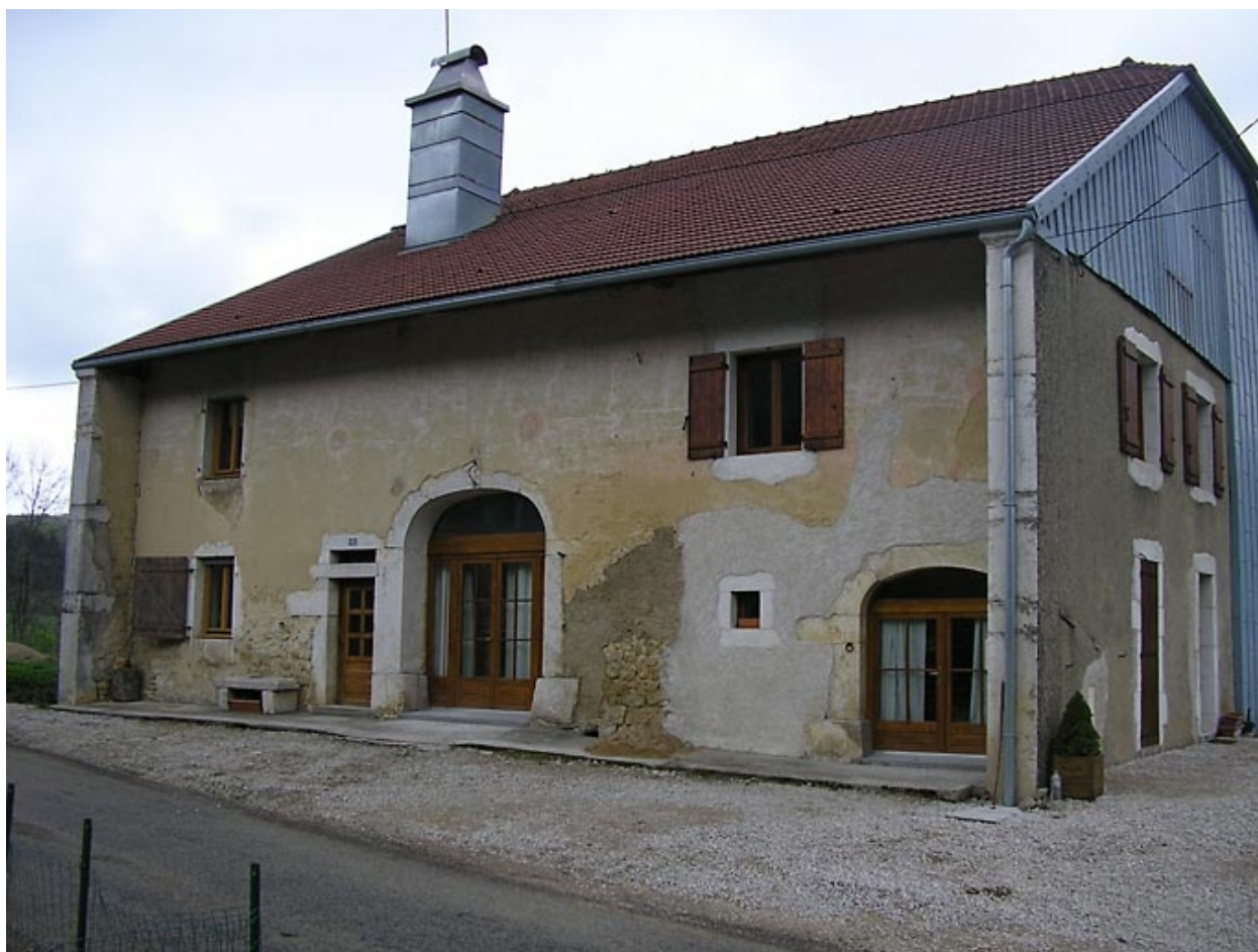
Ferme située au lieu-dit La Ruine.
