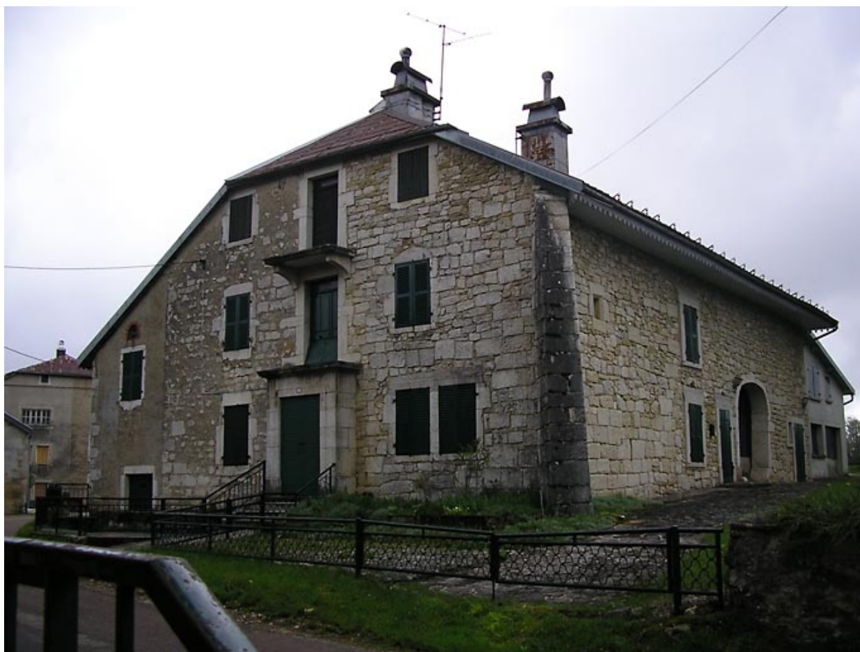
Maison située 88-89 Grande Rue.
