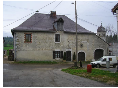
ferme située 108 Grande Rue. Phot. Marie-Pierre Reynet IVR43_20083900385NUC1A
