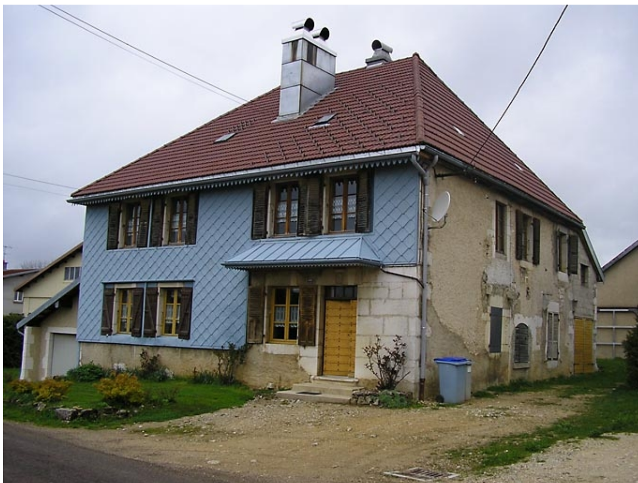
Maison située 77 Grande Rue.
