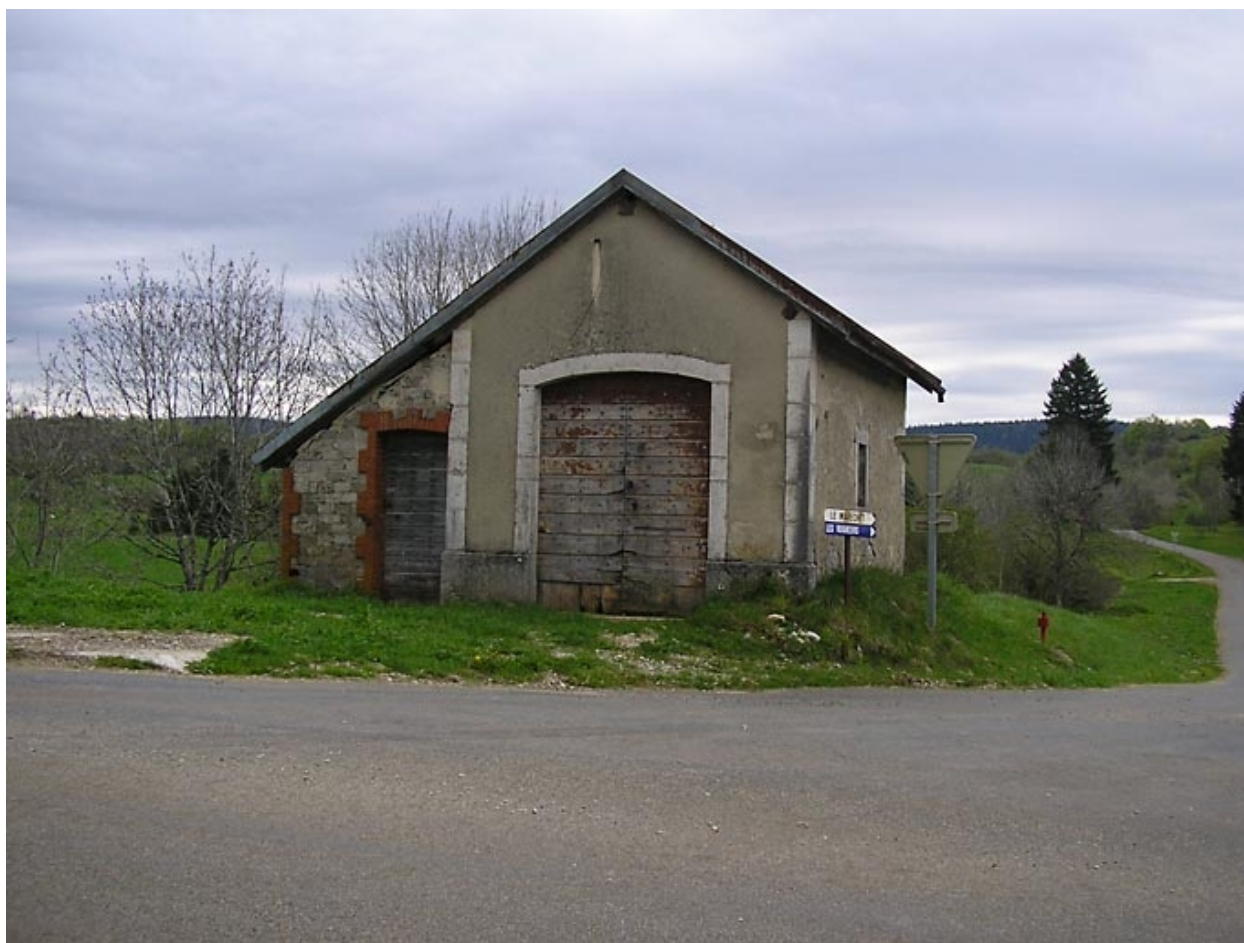
La remise de matériel d'incendie.
