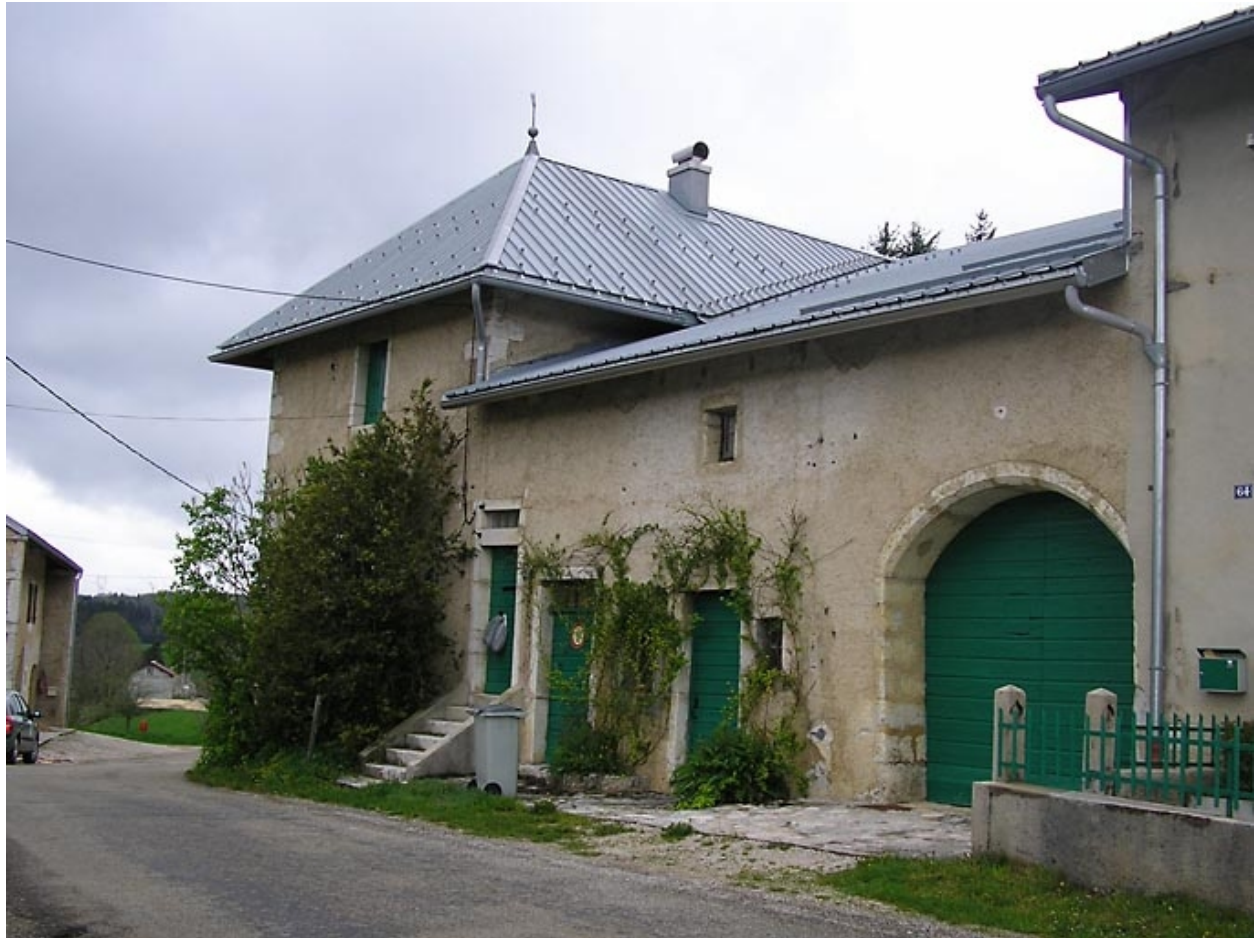
Ferme située au lieu-dit La Ruine.
