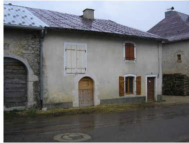
Ferme située 109 Grande Rue. Phot. Marie-Pierre Reynet IVR43_20083900384NUC1A
