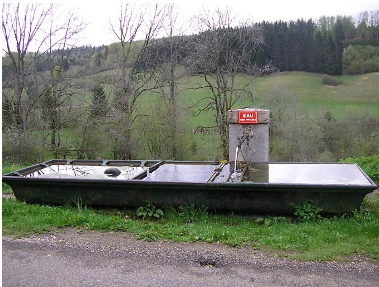
Fontaine située au lieu-dit La Ruine.
