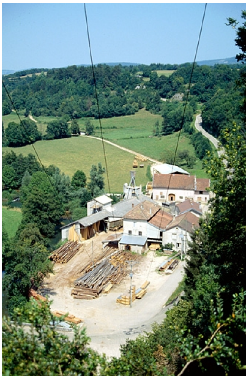
Vue d'ensemble plongeante depuis le sud.
