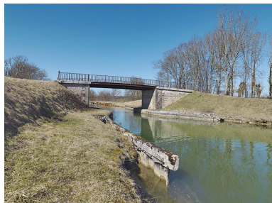
Vue d'ensemble du pont.
