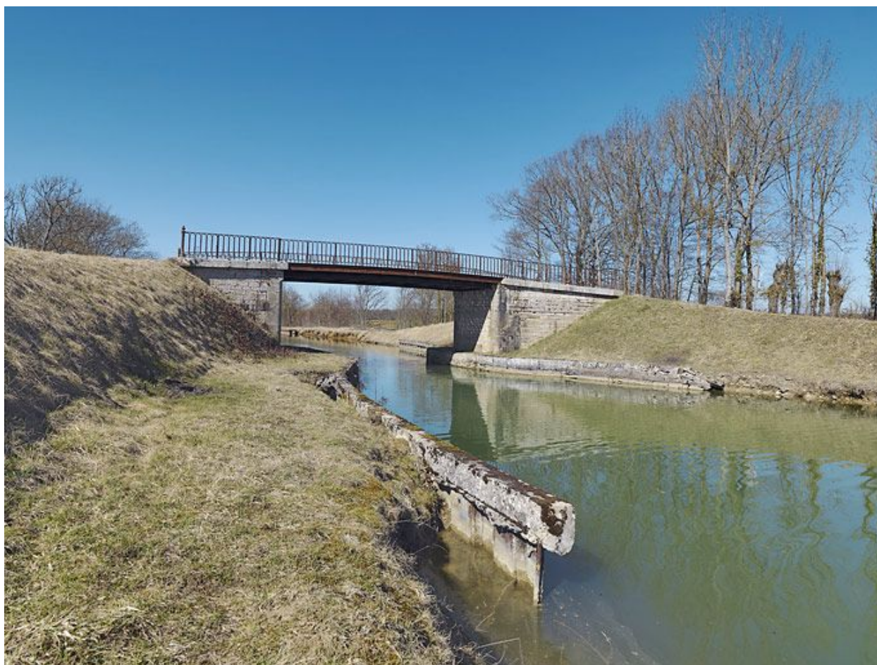
Vue d'ensemble du pont.
