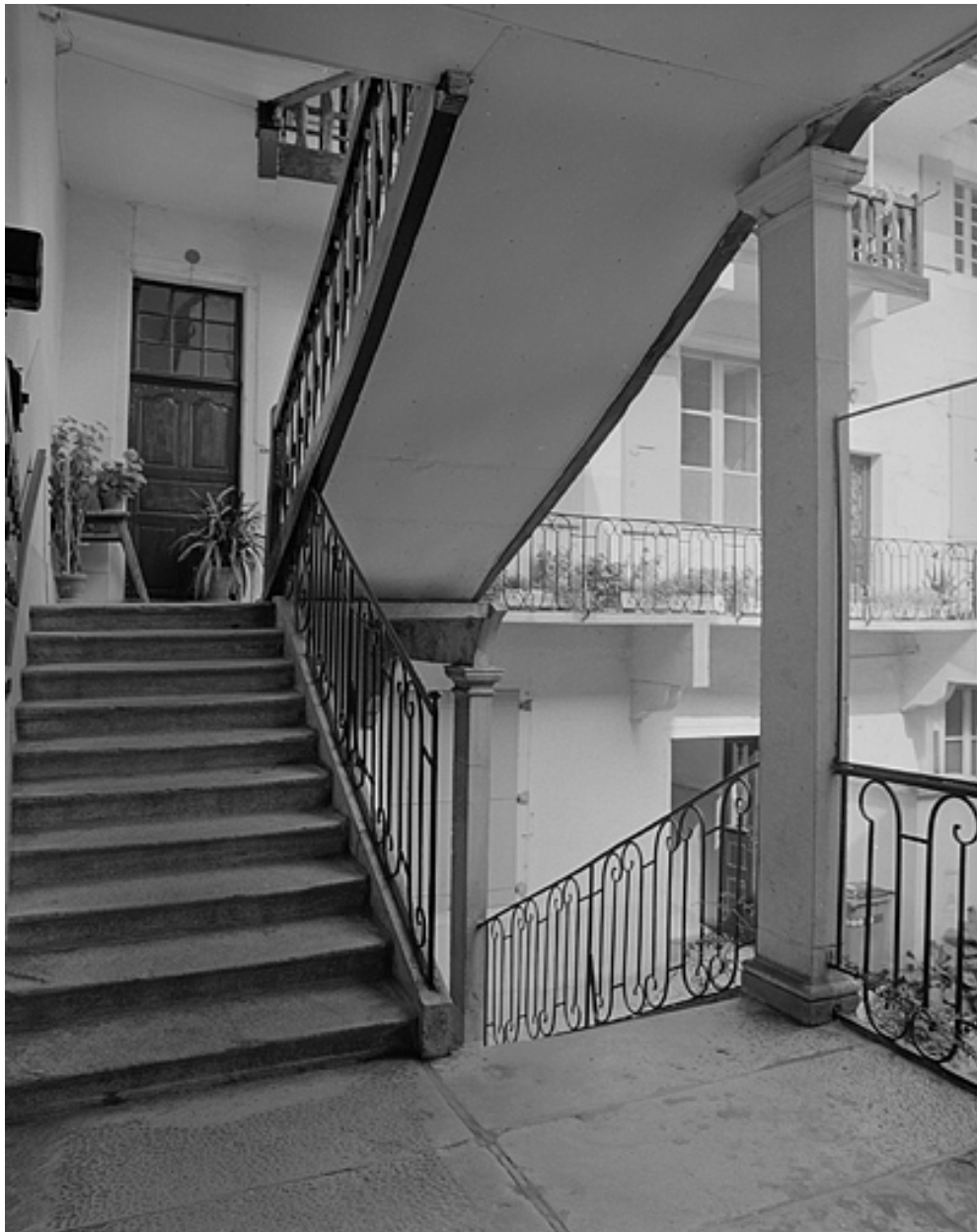
Escalier vu depuis le premier palier.
