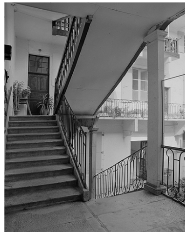
Escalier vu depuis le premier palier. Phot. Yves Sancey IVR43_19833900298X
