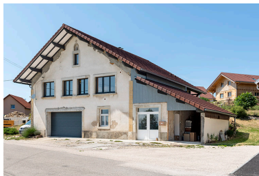
Façade antérieure, de trois quarts droite. Phot. Sonia Dourlot IVR43_20192500668NUC4A
