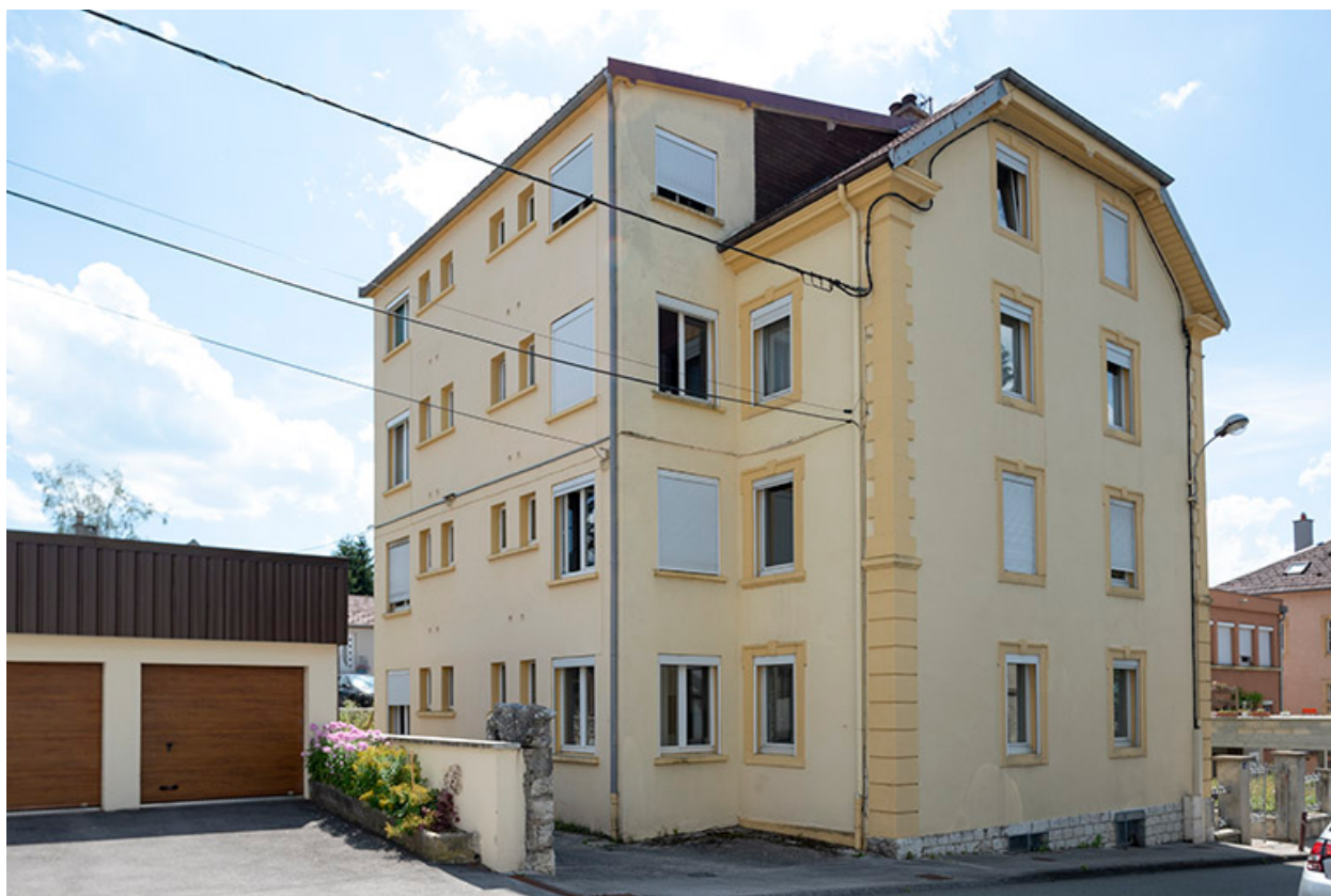
Façades postérieure et latérale gauche.
