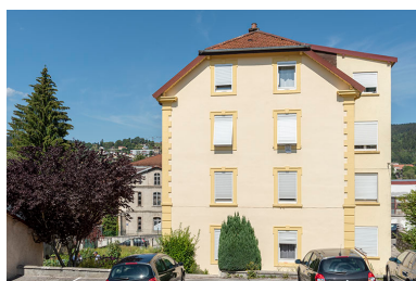
Façade latérale droite. Phot. Sonia Dourlot IVR43_20182501233NUC4A
