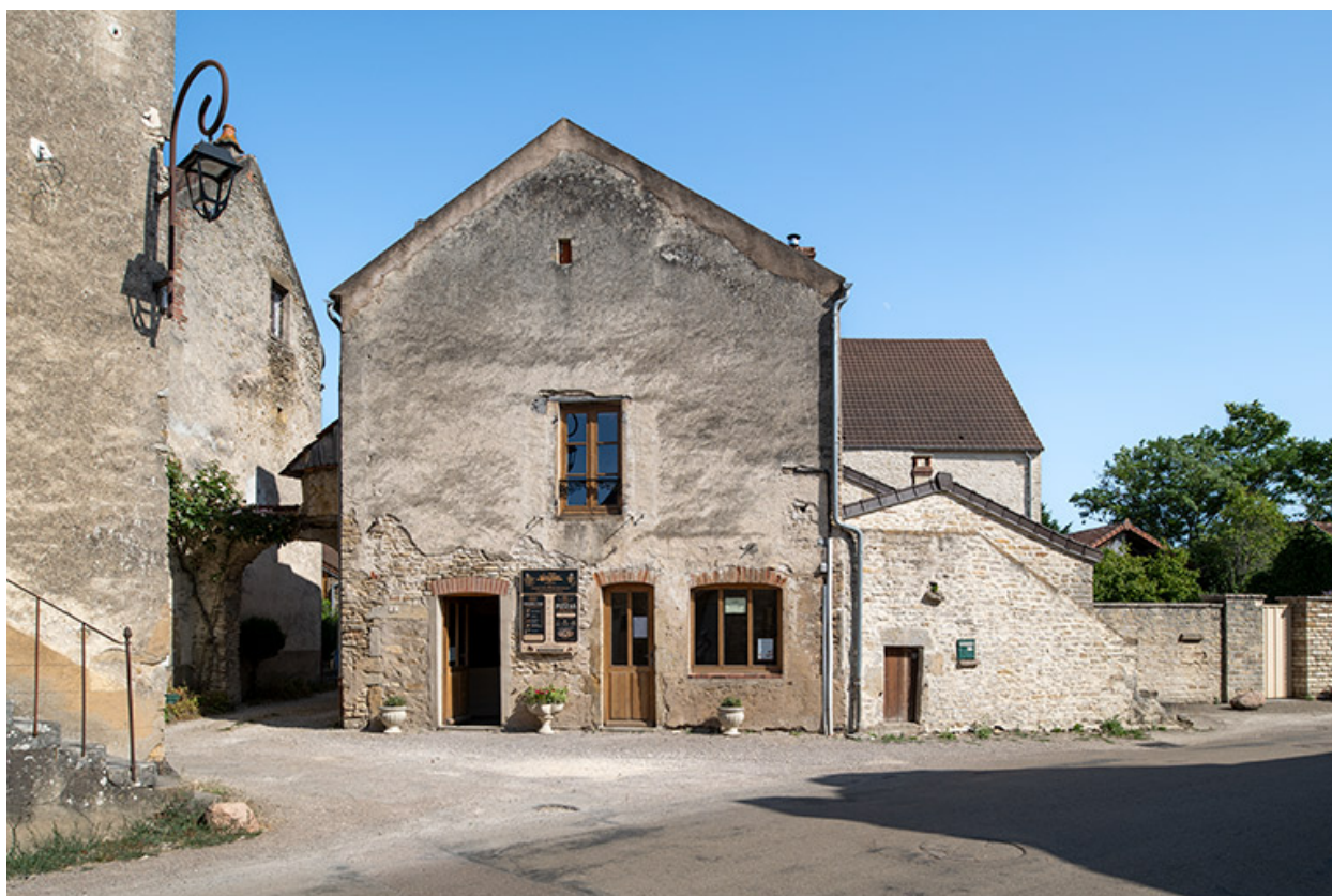
Le pignon de la maison vue de la rue de la Mairie.
