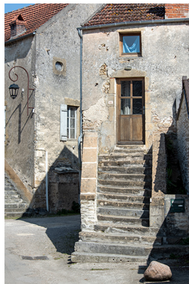
L'escalier d'accès de face. Phot. Nicolas Waltefaugle IVR26_20268900108NUC4A
