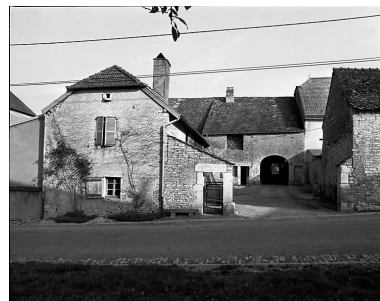
Ferme située 9 Grande Rue à Vantoux. Phot. Dominique Dominguez IVR43_19807000360X
