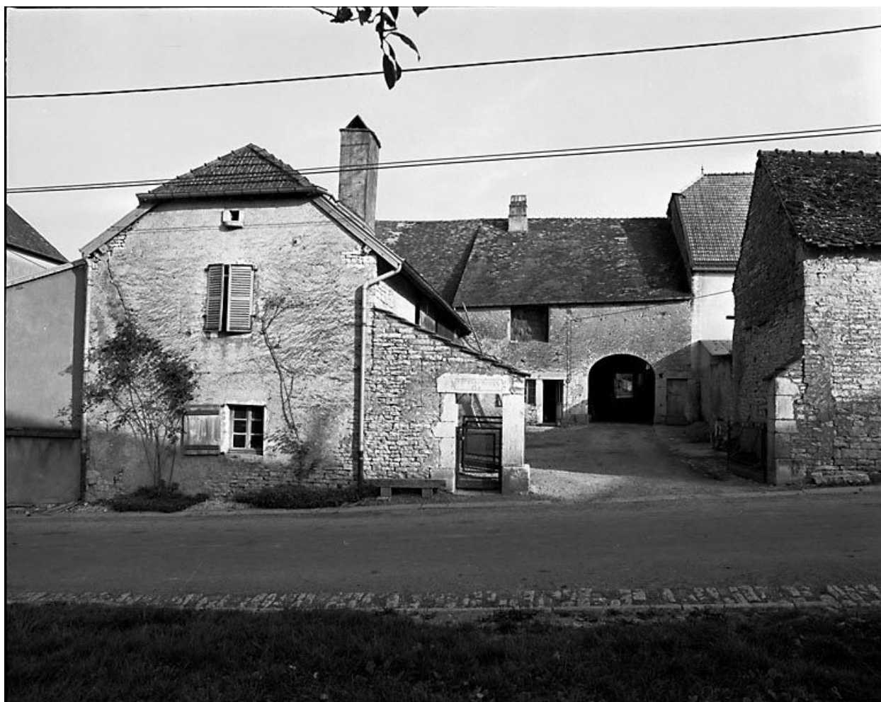
Ferme située 9 Grande Rue à Vantoux.
