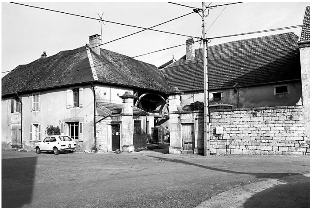
Ferme située 3 Grande Rue à Vantoux.
