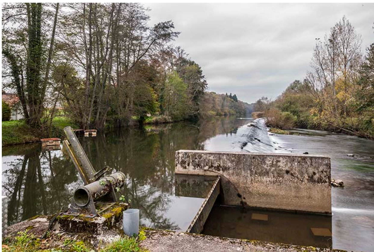
Le barrage sur l'Ognon.
