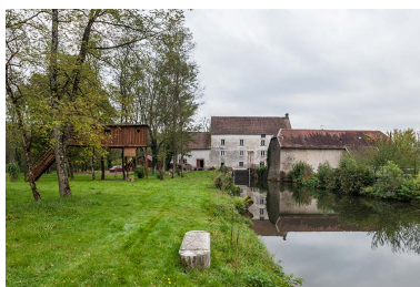
Vue d'ensemble depuis le bief d'amenée. Phot. Jérôme Mongreville IVR43_20142501660NUC4A
