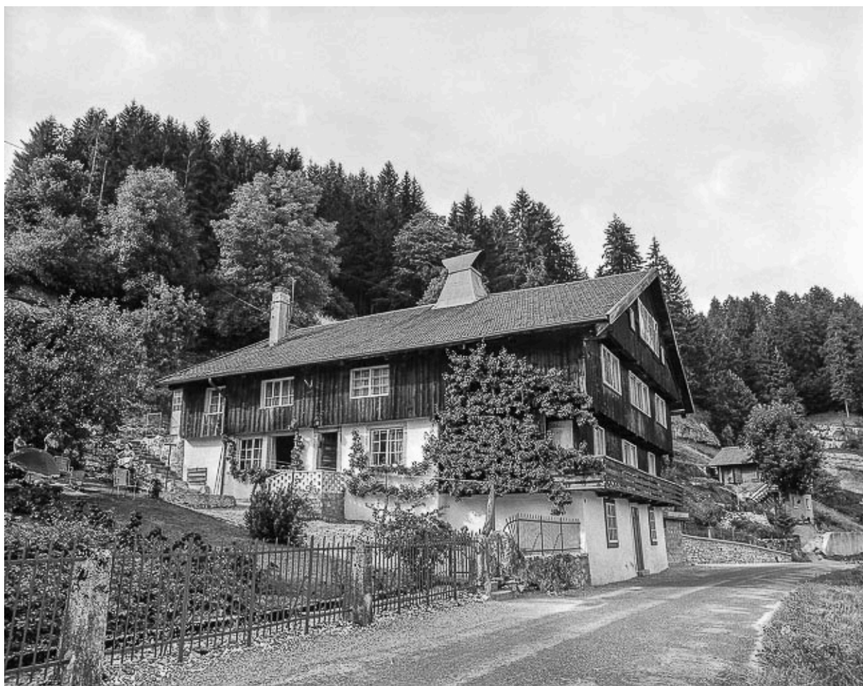
Vue d'ensemble depuis le sud, en 1976.
