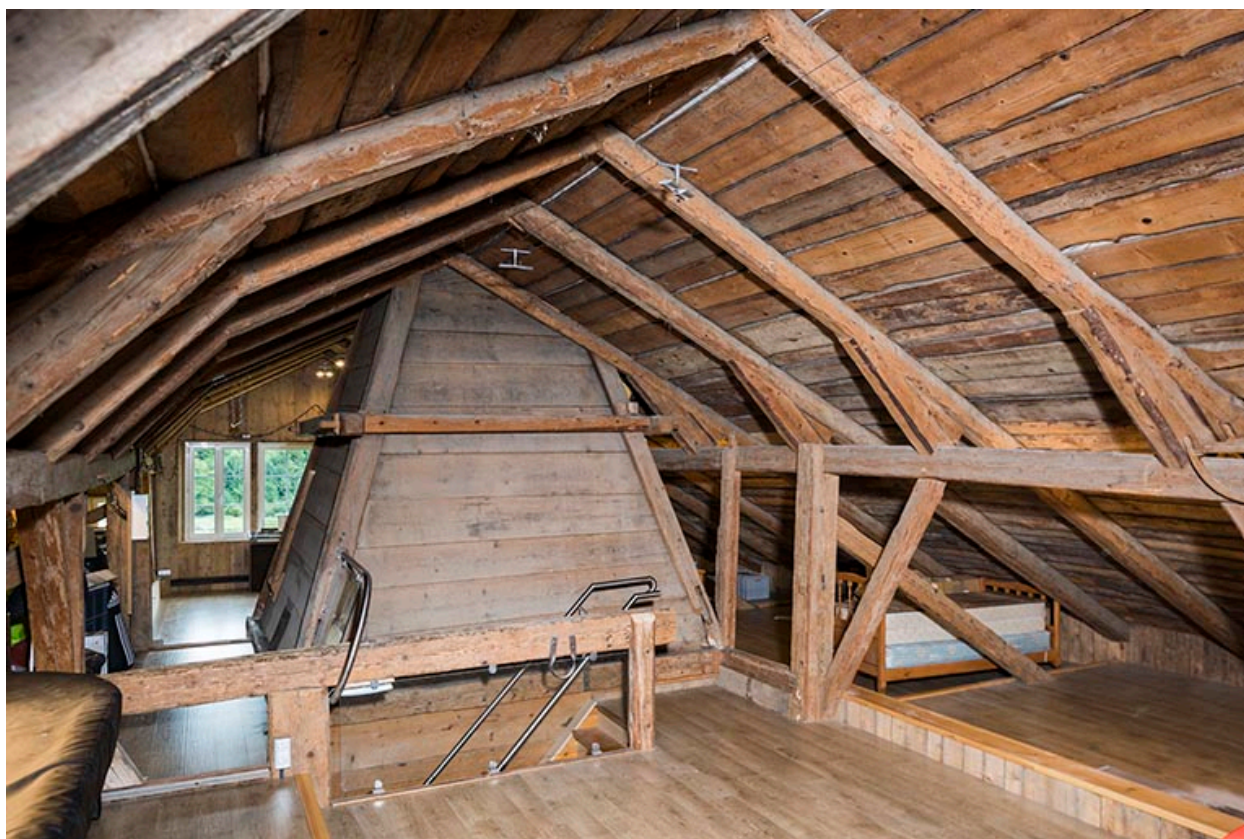
Etage en surcroît : charpente et tué.
