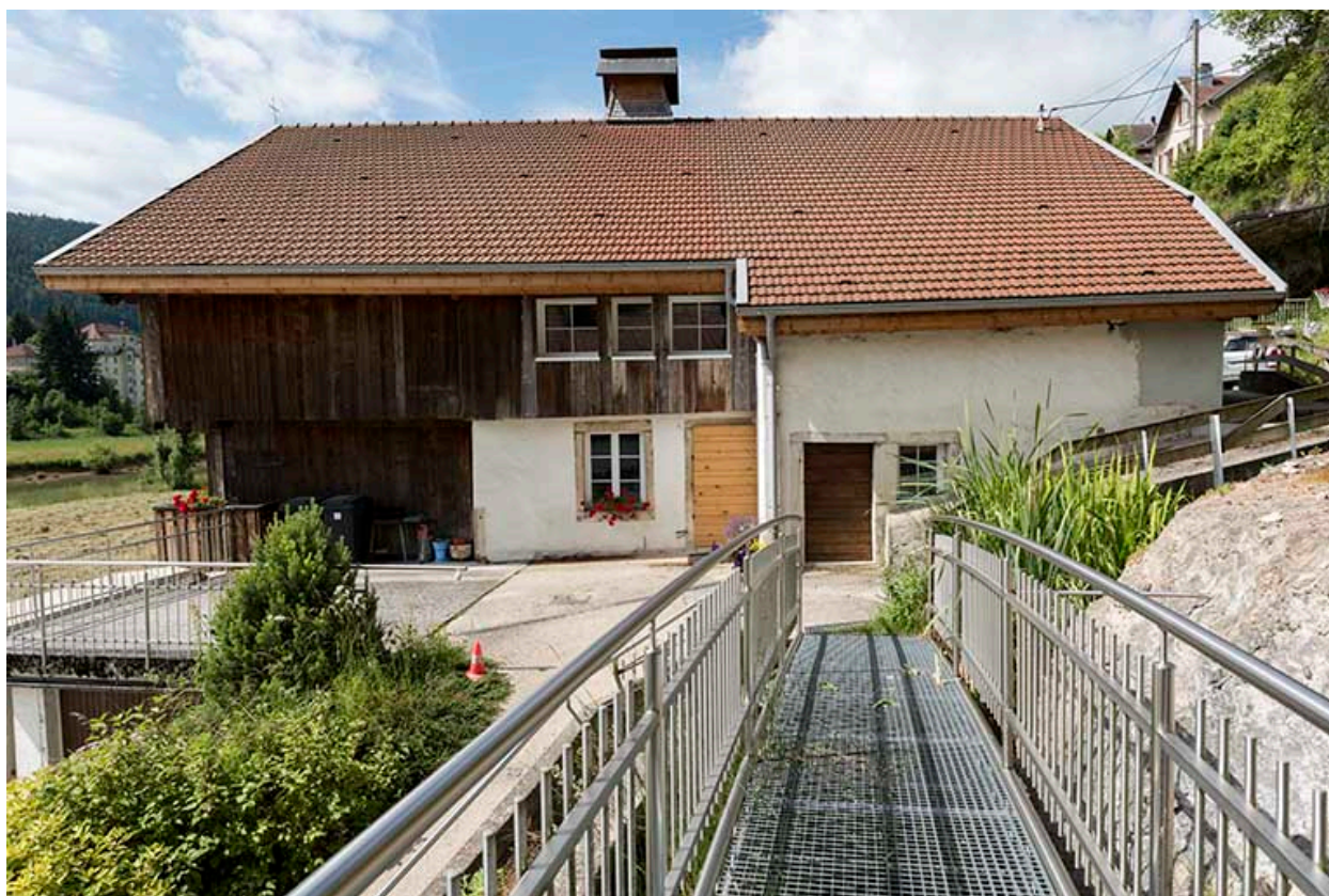
Façade latérale droite.
