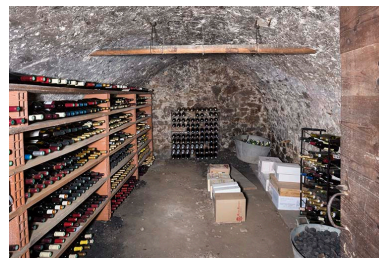
Deuxième étage de soubassement : cellier. Phot. Sonia Dourlot IVR43_20162501313NUC4A
