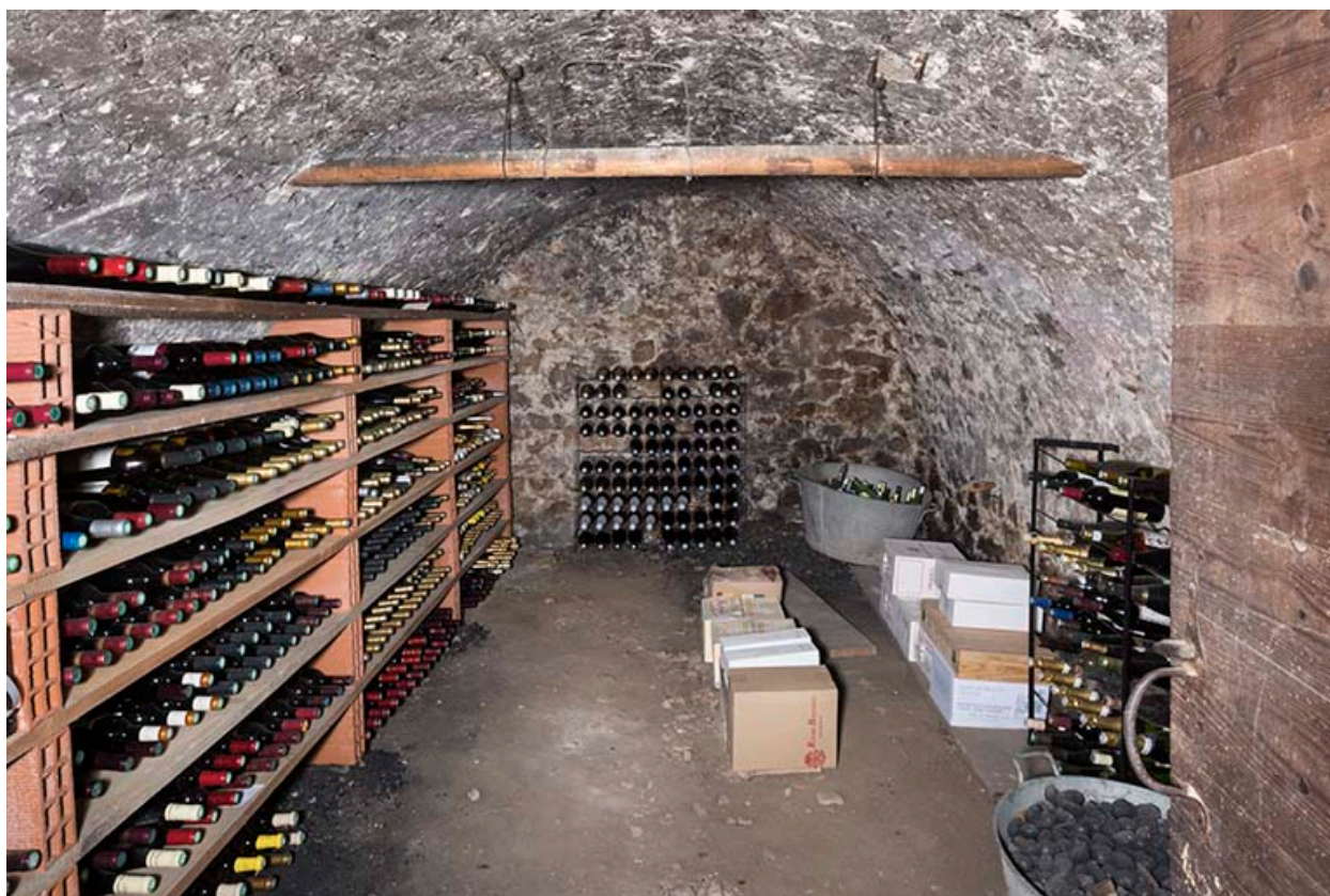
Deuxième étage de soubassement : cellier.
