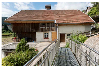
Façade latérale droite. Phot. Sonia Dourlot IVR43_20162501305NUC4A
