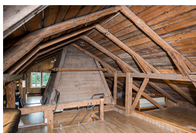
Etage en surcroît : charpente et tué. Phot. Sonia Dourlot IVR43_20162501316NUC4A
