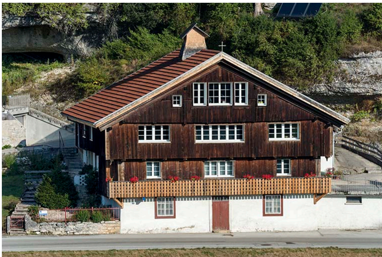
Façade antérieure, vue en plongée.
