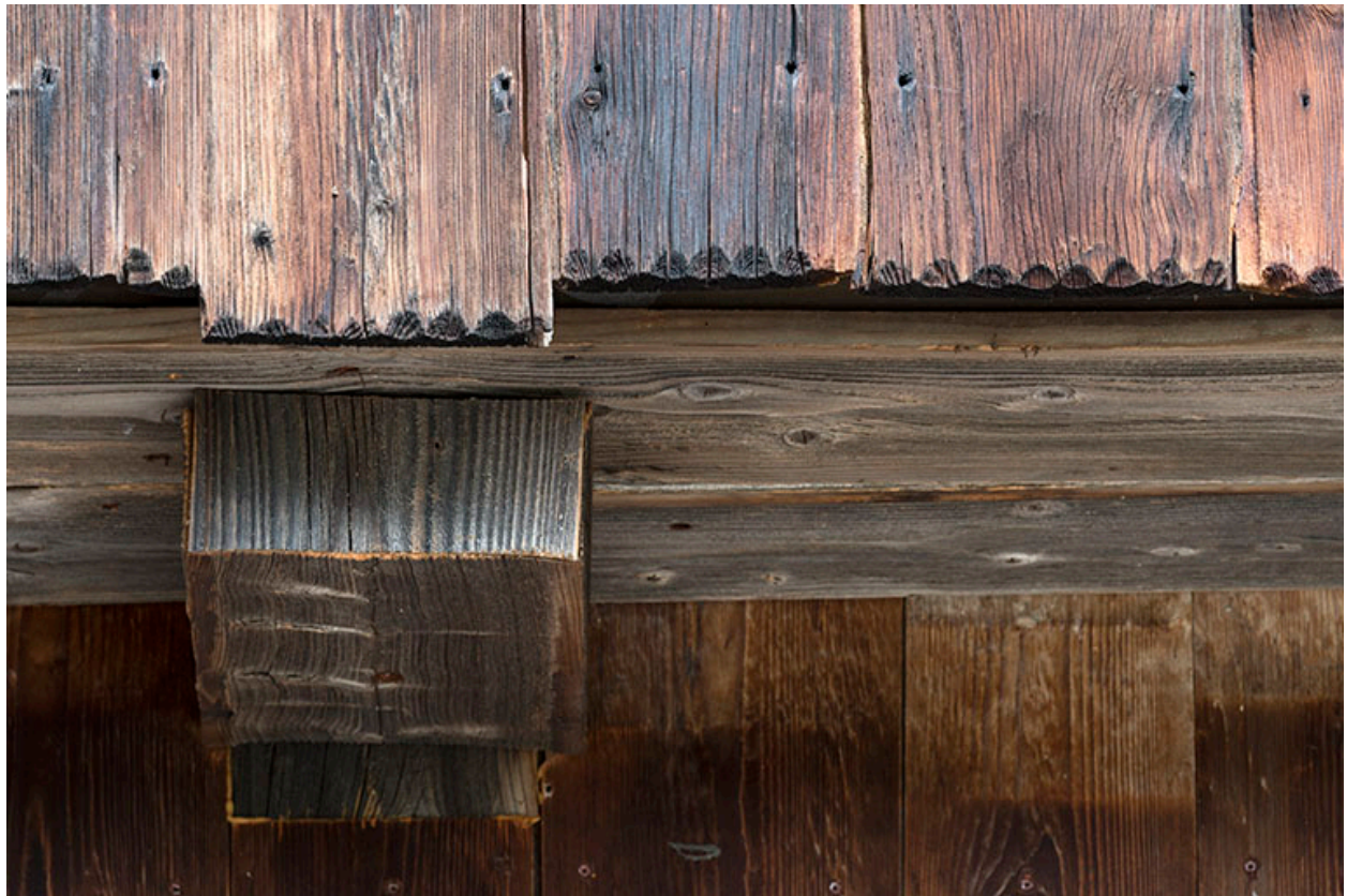
Extrémité des planches de la lambrichure.
