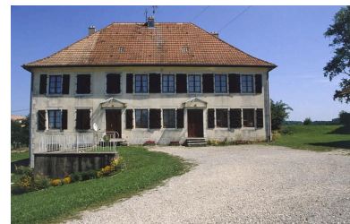
Façade ouest du logement patronal. Phot. Yves Sancey IVR43_20009000311ZA
