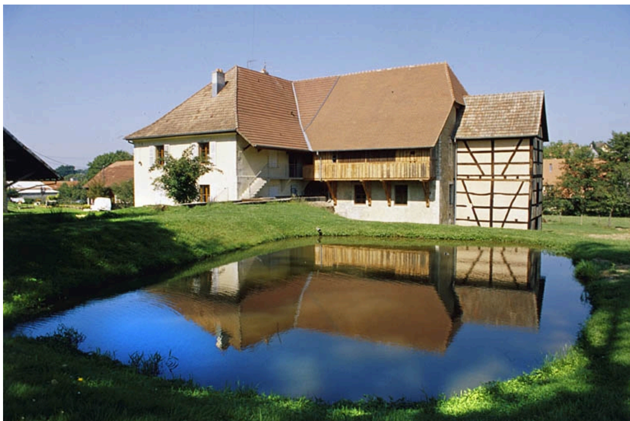
Façades postérieures du moulin.
