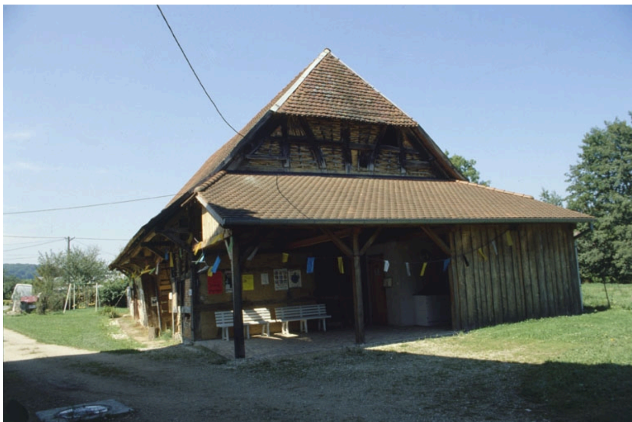
Pignon du bâtiment agricole.
