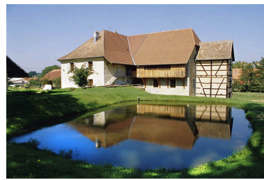
Façades postérieures du moulin. Phot. Yves Sancey IVR43_20009000307ZA
