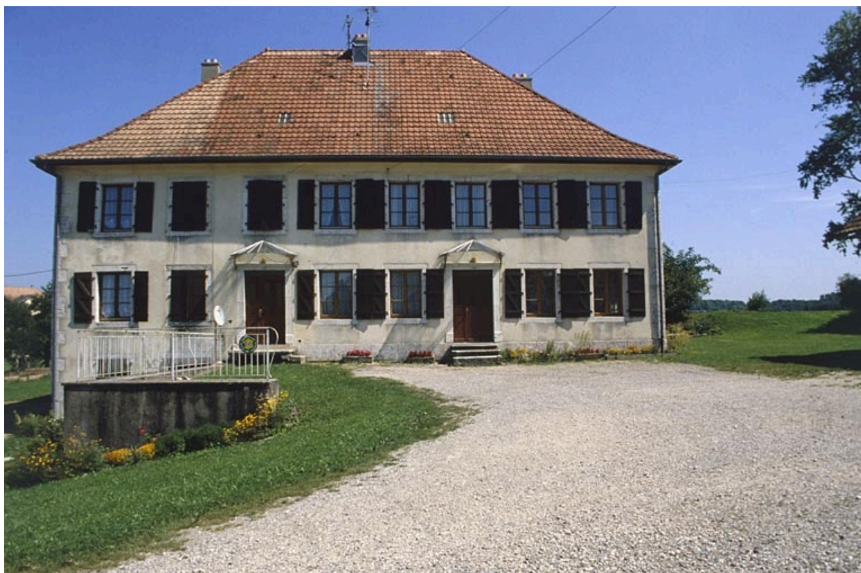
Façade ouest du logement patronal.
