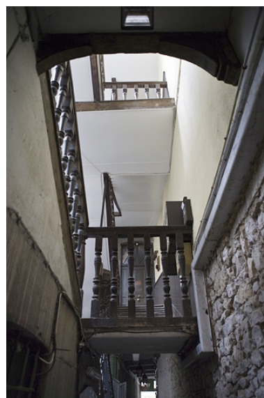
Détail de l'escalier à cage ouverte dans la première cour : 13 Grande Rue. Phot. Yves Sancey IVR43_20102500244NUC2A
