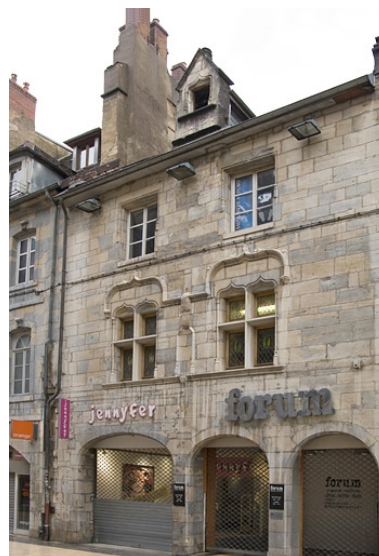
Façade antérieure du 15 Grande Rue : de trois quarts droit. Phot. Yves Sancey IVR43_20102500238NUC2A
