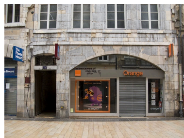
Détail du rez-de-chaussée de la façade antérieure du 13 Grande Rue : de face. Phot. Yves Sancey IVR43_20102500236NUC2A
