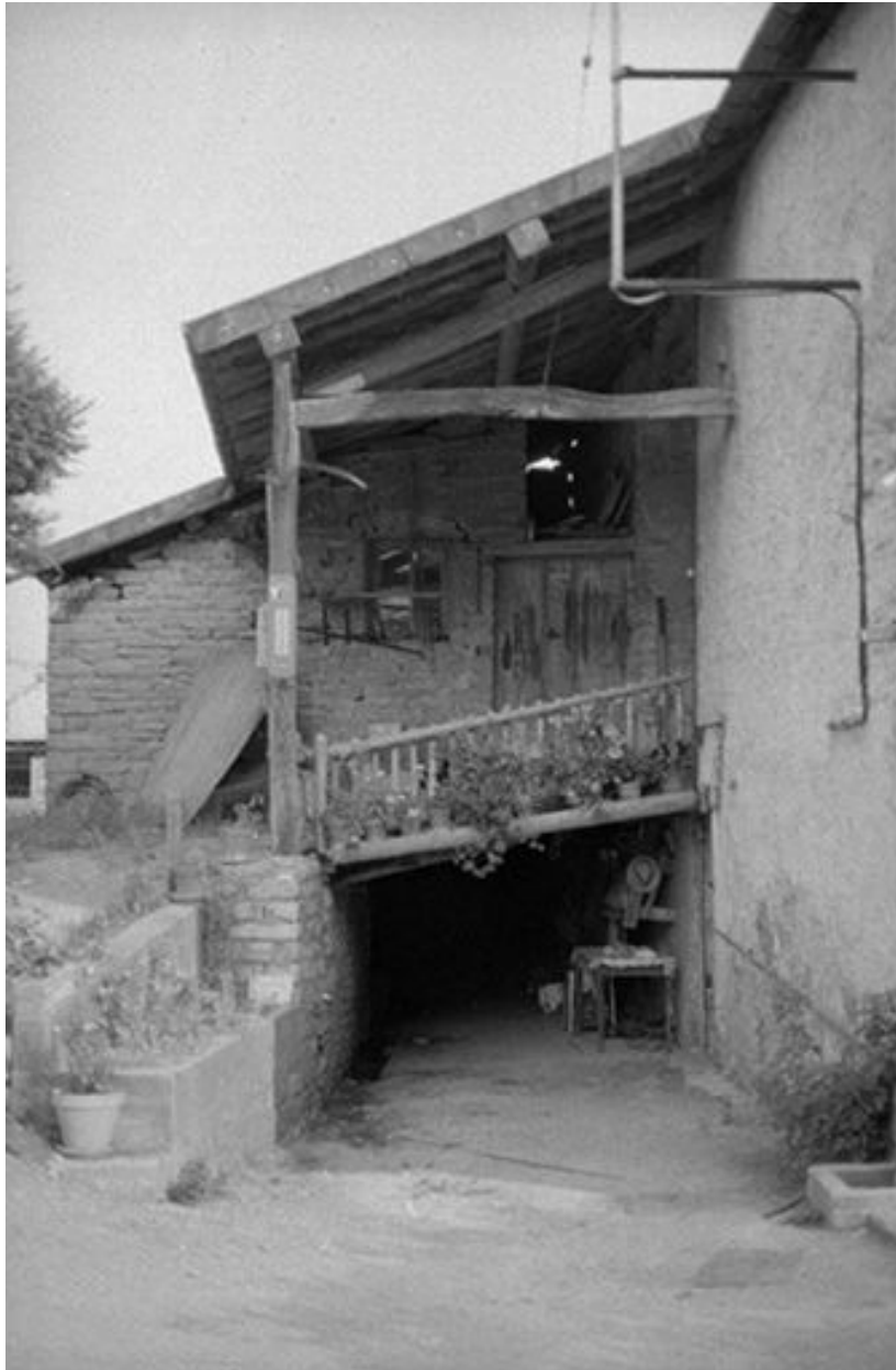
Façade latérale gauche : le pont de grange.
