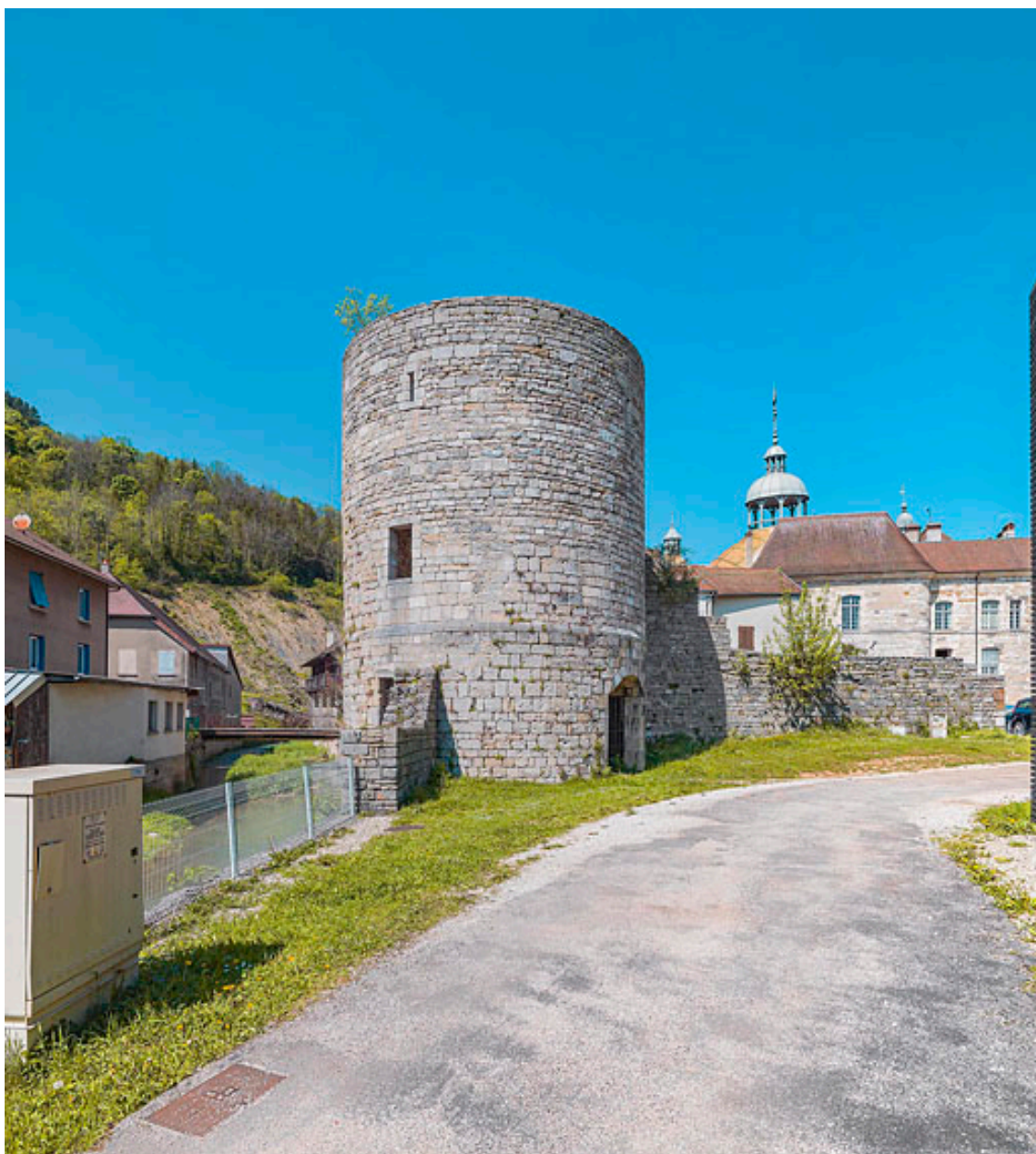
Vue depuis le sud.
