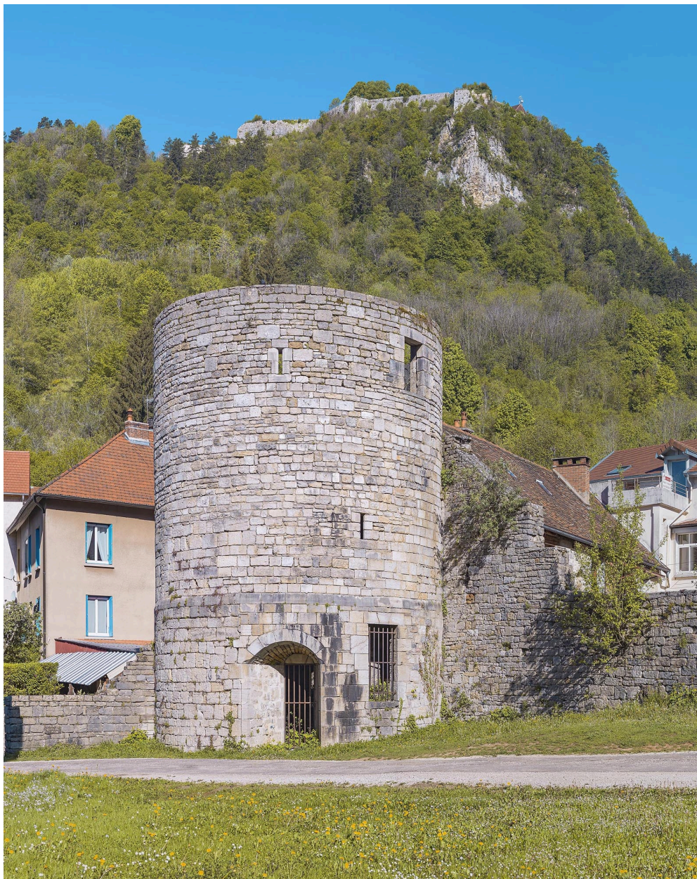
Vue depuis le sud-est.
