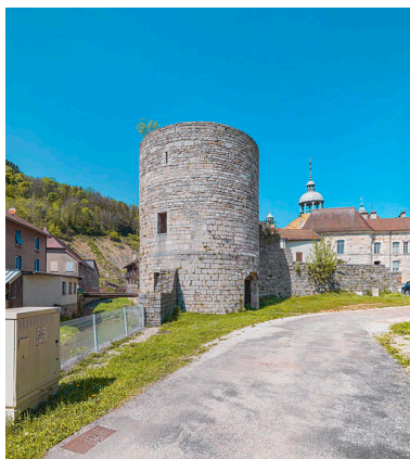
Vue depuis le sud. Phot. Thierry Kuntz IVR43_20223900623NUC4A
