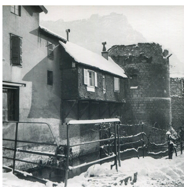
Vue depuis le pont de Saint- Nicolas, milieu 20e siècle. Phot. Georges Chenu IVR43_20243900157NUC4A
