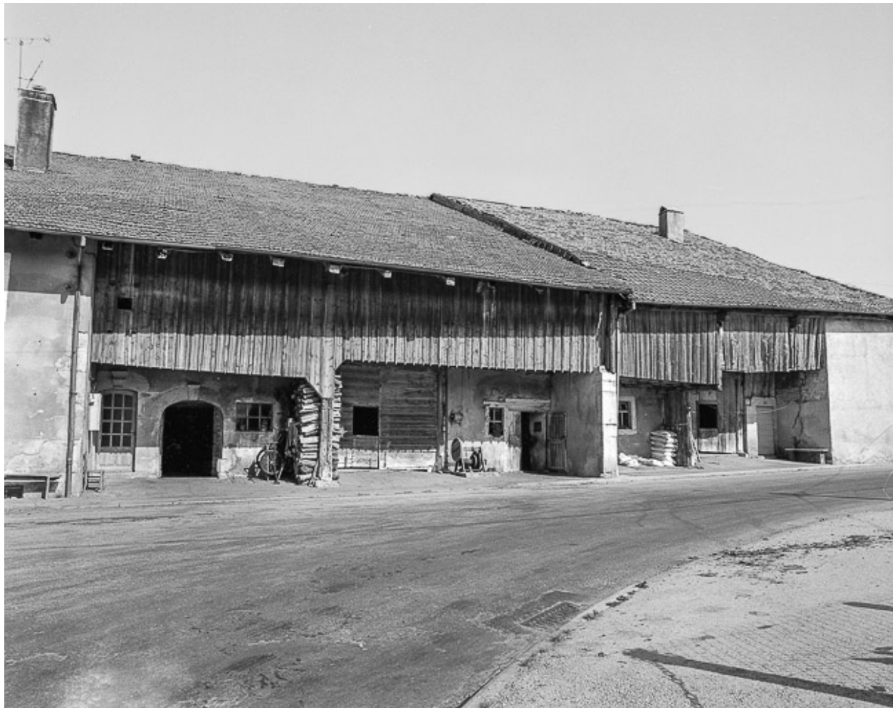
Goutterot sur rue.
