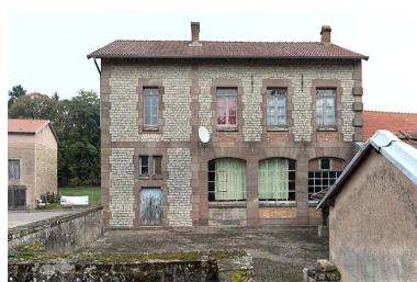
Façade postérieure et cour. Phot. Sonia Dourlot IVR43_20157001404NUC4A
