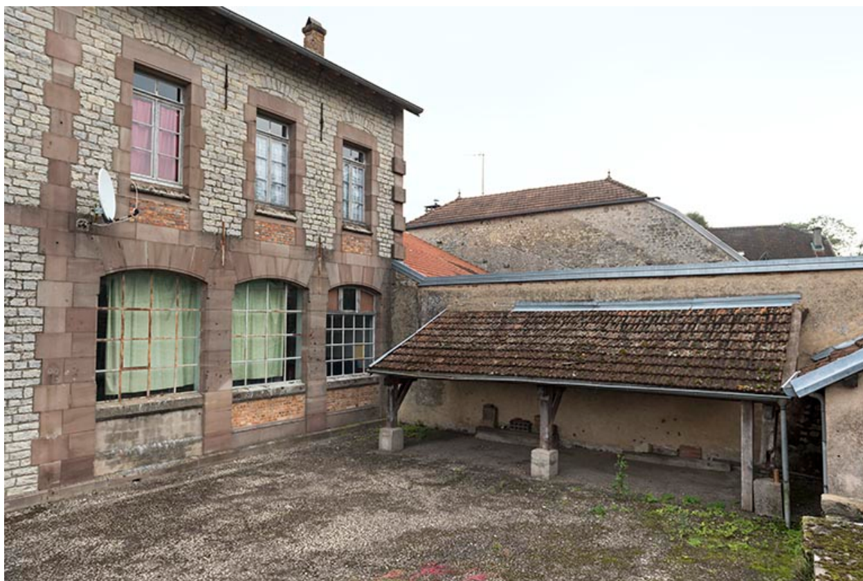
Cour, préau, détail de la façade postérieure.
