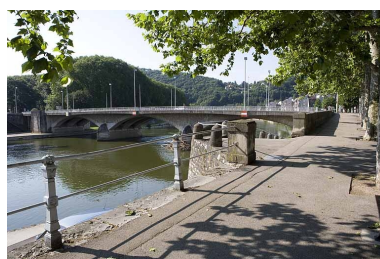
Garde-corps métallique et rampe d'accès au port. Phot. Yves Sancey IVR43_20062500236NUCA
