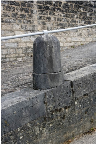
Borne monolithe de la rampe d'accès.
