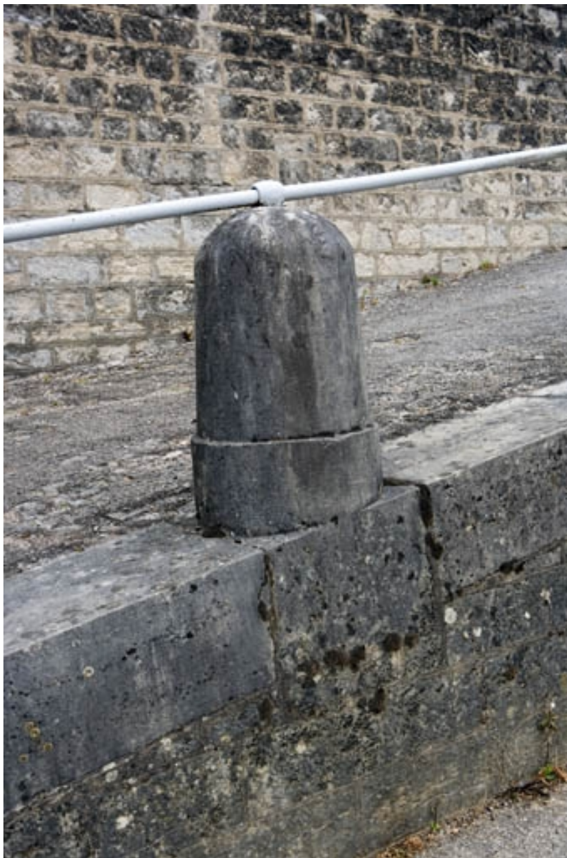
Borne monolithe de la rampe d'accès.
