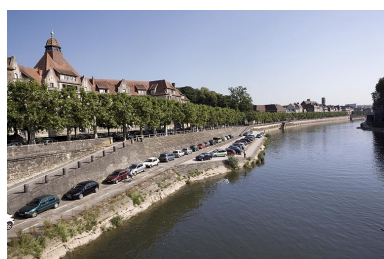
Vue d'ensemble depuis le pont de Canot. Phot. Yves Sancey IVR43_20062500234NUCA
