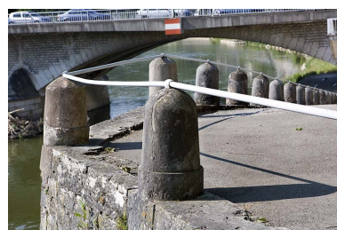
Bornes et garde-corps de la rampe d'accès. Phot. Yves Sancey IVR43_20062500235NUCA
