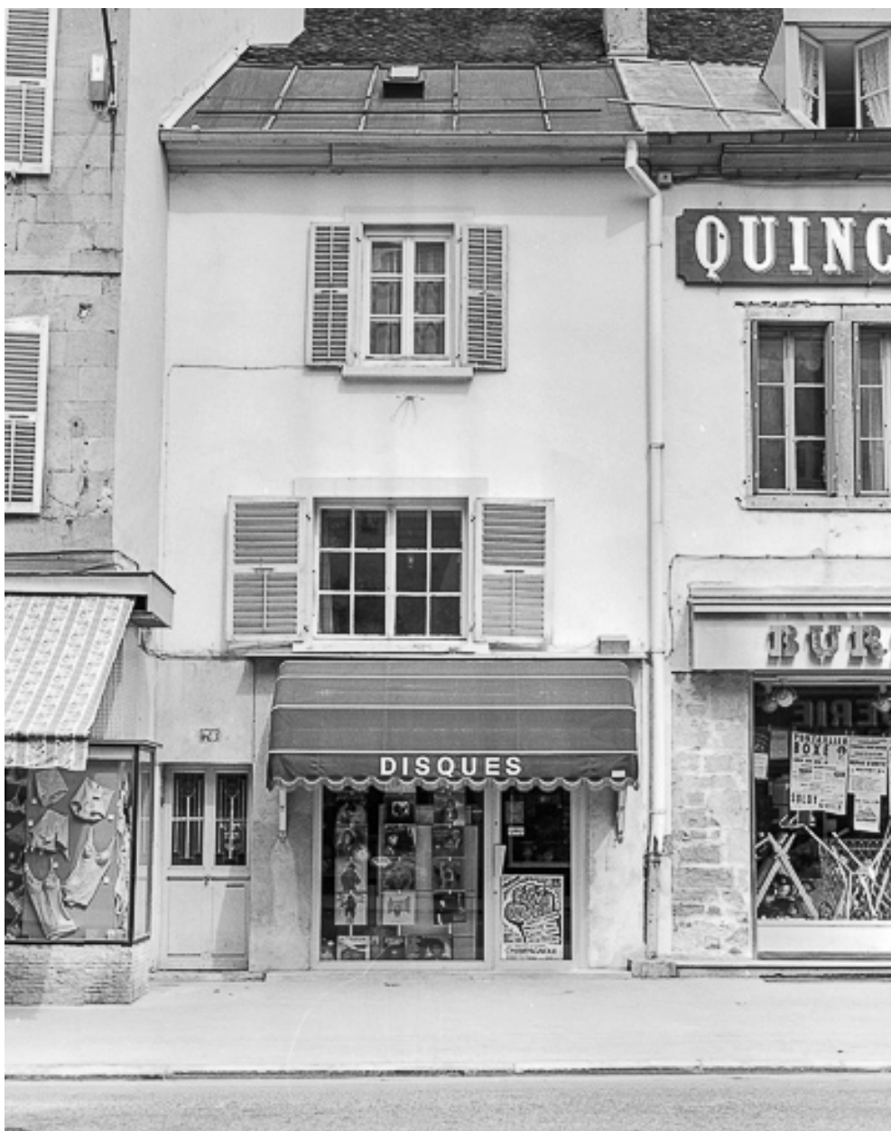
Façade sur rue, vue de face.
