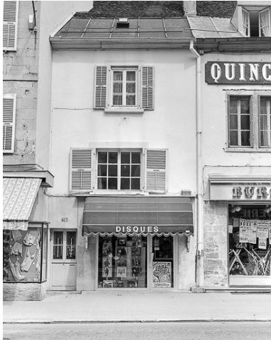
Façade sur rue, vue de face.
