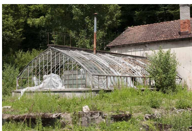
Serre vue de trois quarts. Phot. Jérôme Mongreville IVR43_20112501164NUC4A
