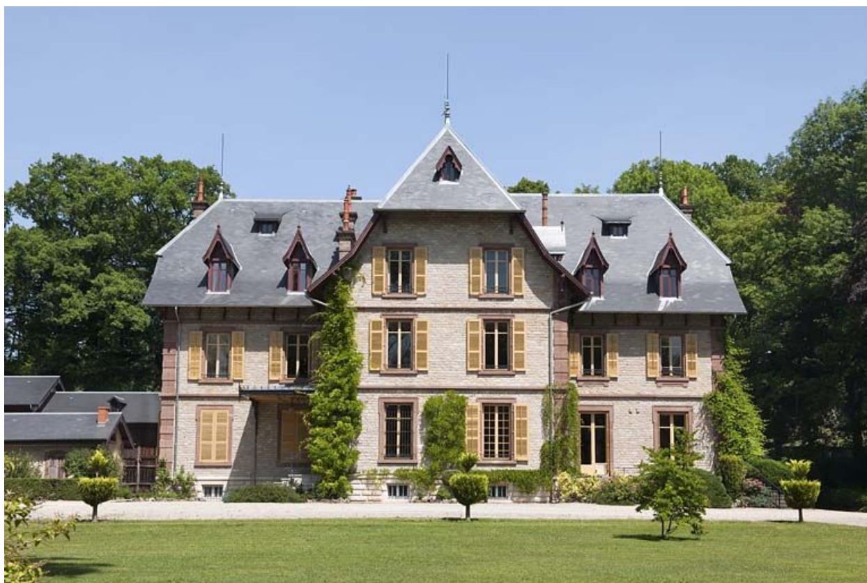
Vue rapprochée de la façade antérieure.
