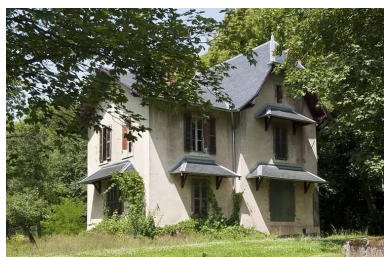
Logement du jardinier. Phot. Jérôme Mongreville IVR43_20112501167NUC4A
