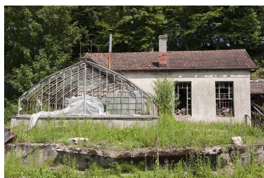
Serre adossée à une resserre. Phot. Jérôme Mongreville IVR43_20112501165NUC4A
