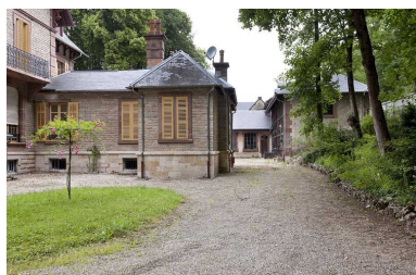
Façade sud de l'annexe et communs. Phot. Jérôme Mongreville IVR43_20112501155NUC4A
