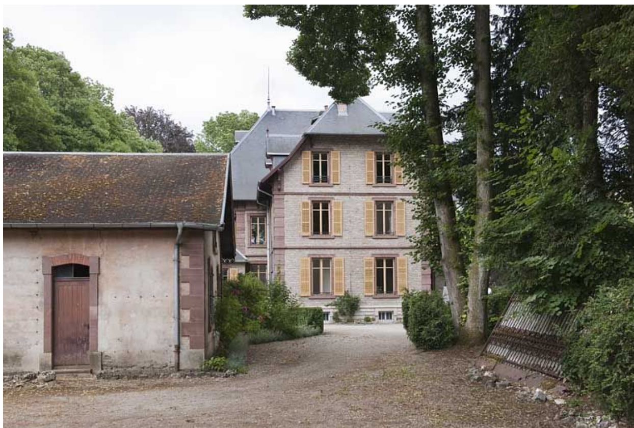
Pignon nord de la demeure.
