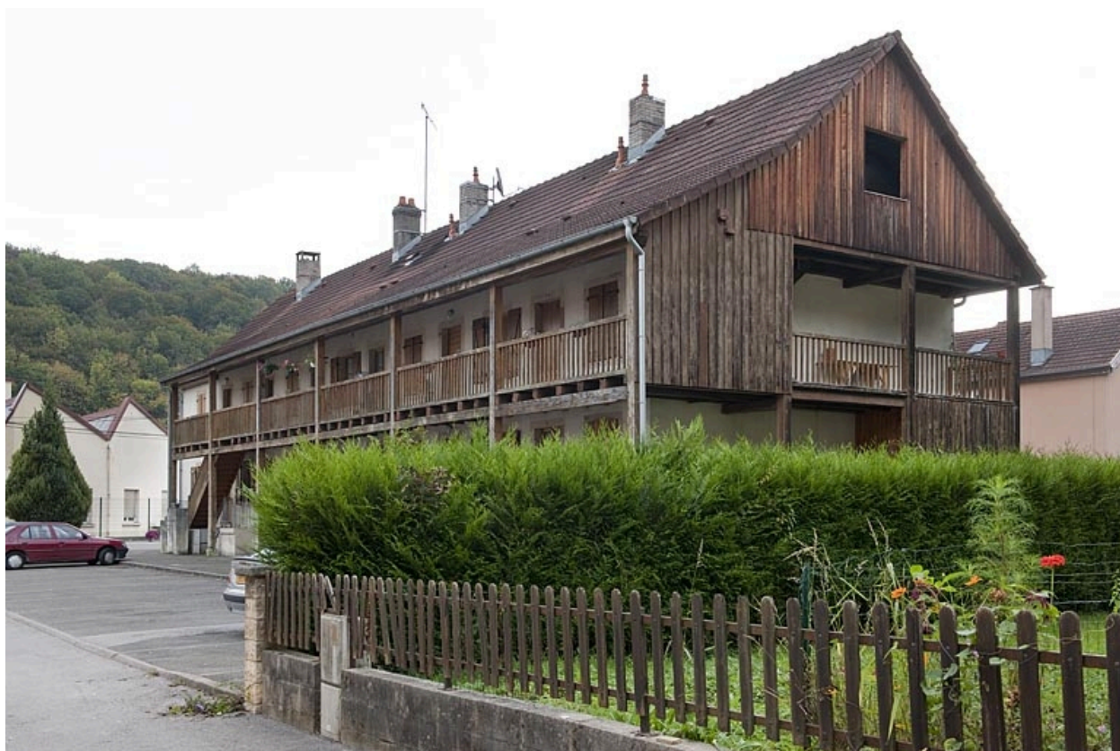
Vue de trois quarts depuis l'ouest.
