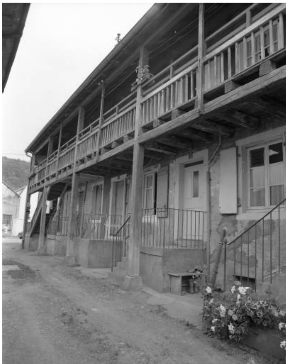
Façade nord et galerie en bois en 1981.
