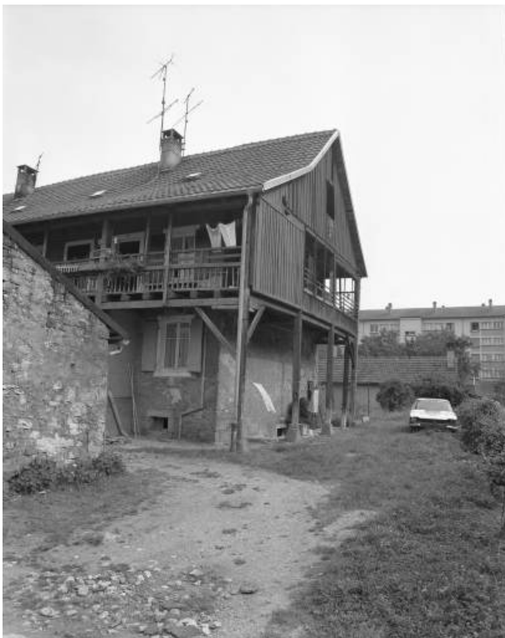
Pignon ouest en 1981.
