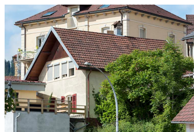
Façade latérale droite.
