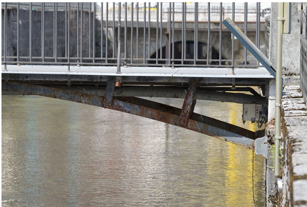
Passerelle aval : détail de l'extrémité rive droite.
