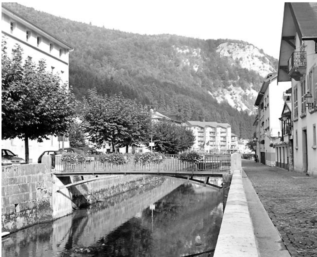
Passerelle amont, vue de l'amont.
