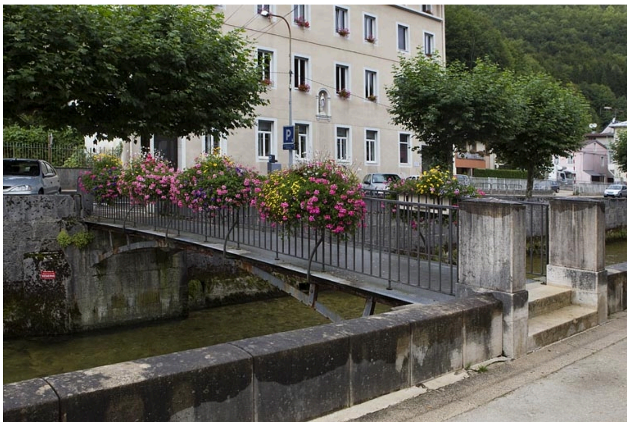
Passerelle amont, vue de trois quarts droite.
