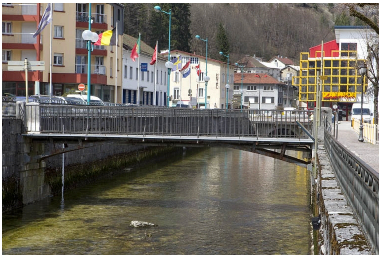
Passerelle aval, vue de l'amont.
