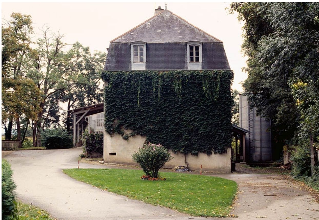
Façade latérale depuis le nord.
