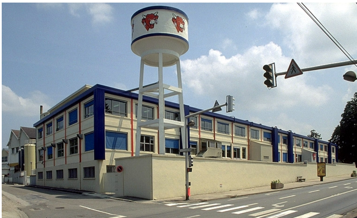
Atelier de fabrication depuis l'est.
