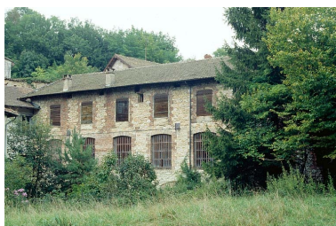
Atelier de fabrication (N) vu du sud. Phot. Laurent Poupard IVR43_19933900471ZA
