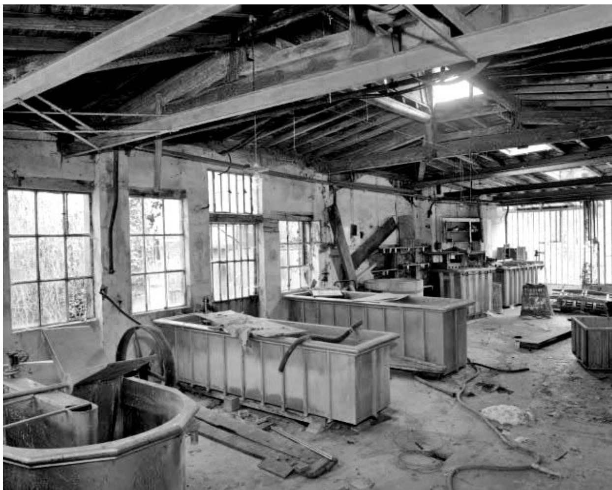
Intérieur de l'atelier de teinture (bâtiment P).
