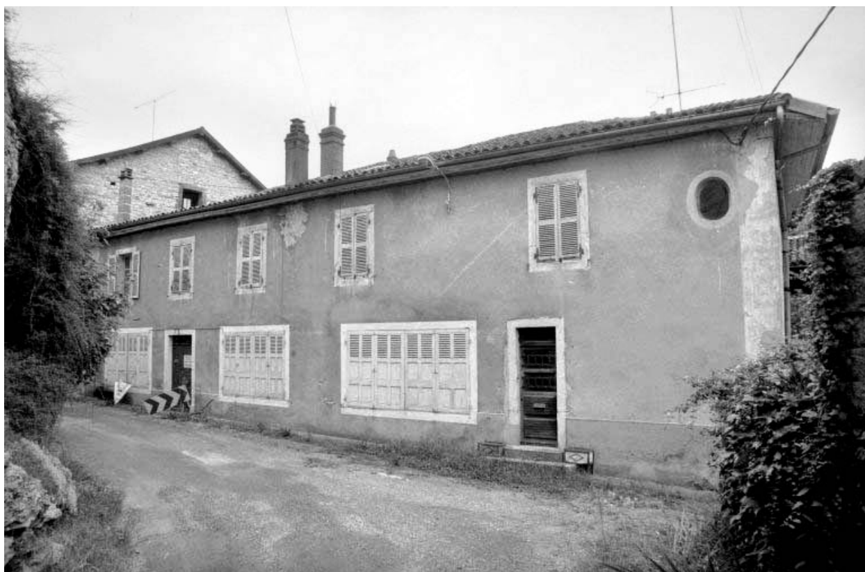
Bureau et logement (K).
