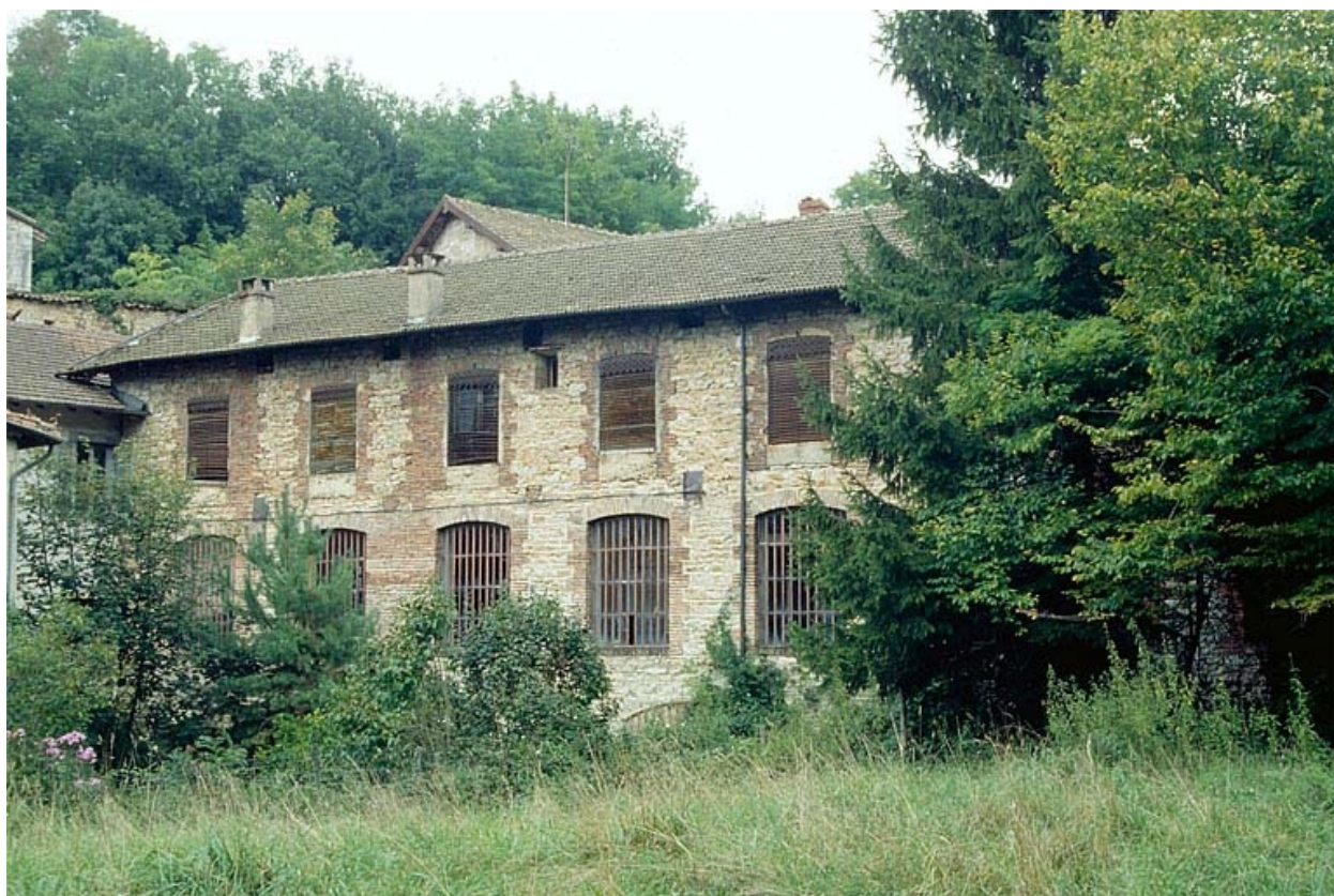
Atelier de fabrication (N) vu du sud.
