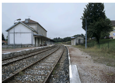
Bâtiment des voyageurs et abri : vue d'ensemble, depuis le nord (côté Andelot-en-Montagne).
