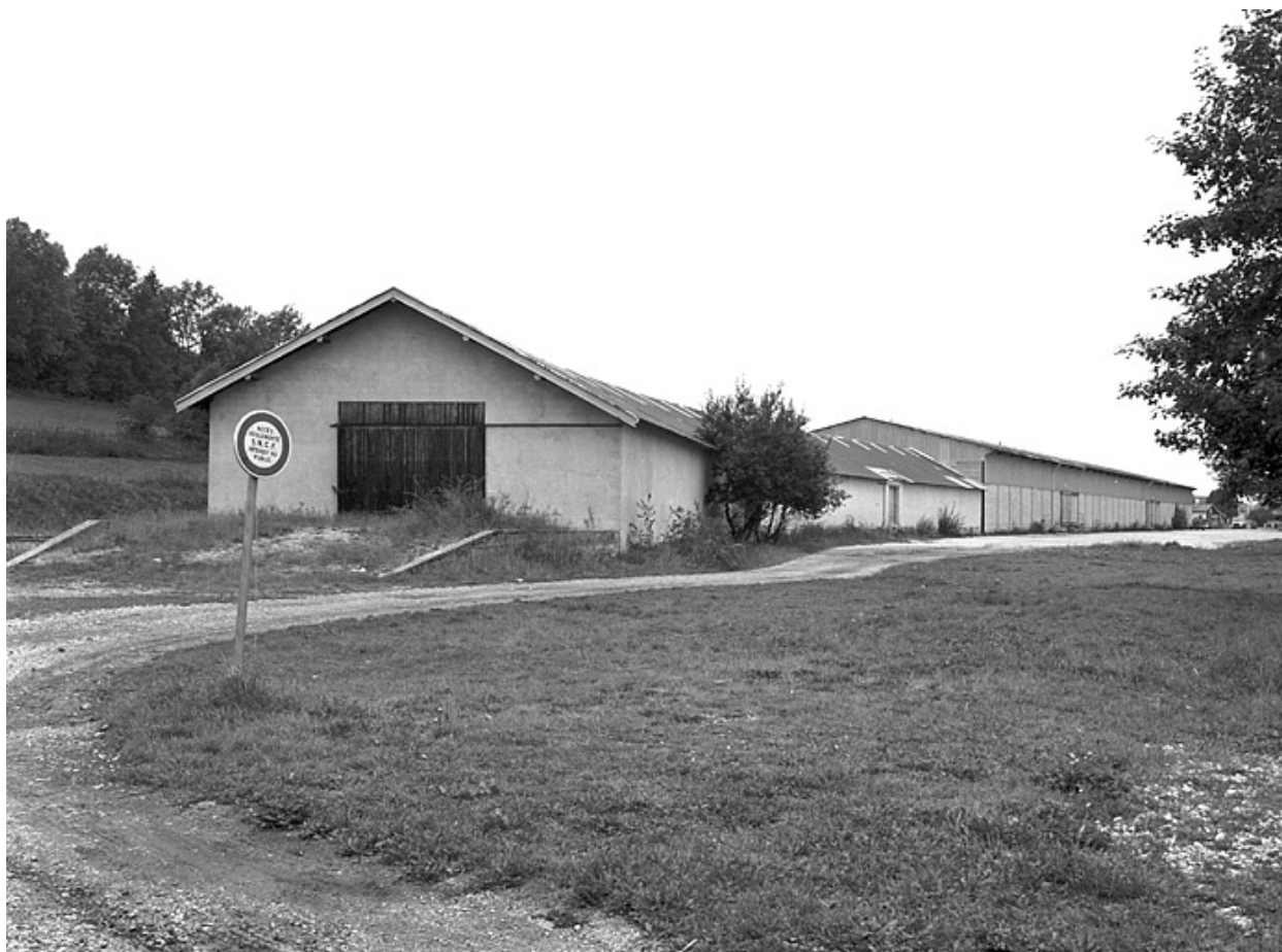
Entrepôts, depuis le sud-est.
