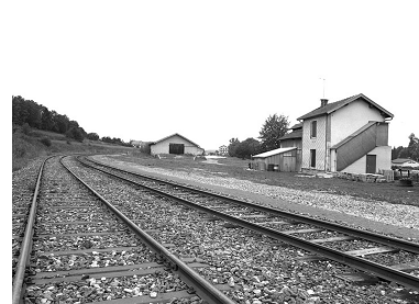
Vue d'ensemble, depuis le sud-est. Phot. Yves Sancey IVR43_20043900257X
