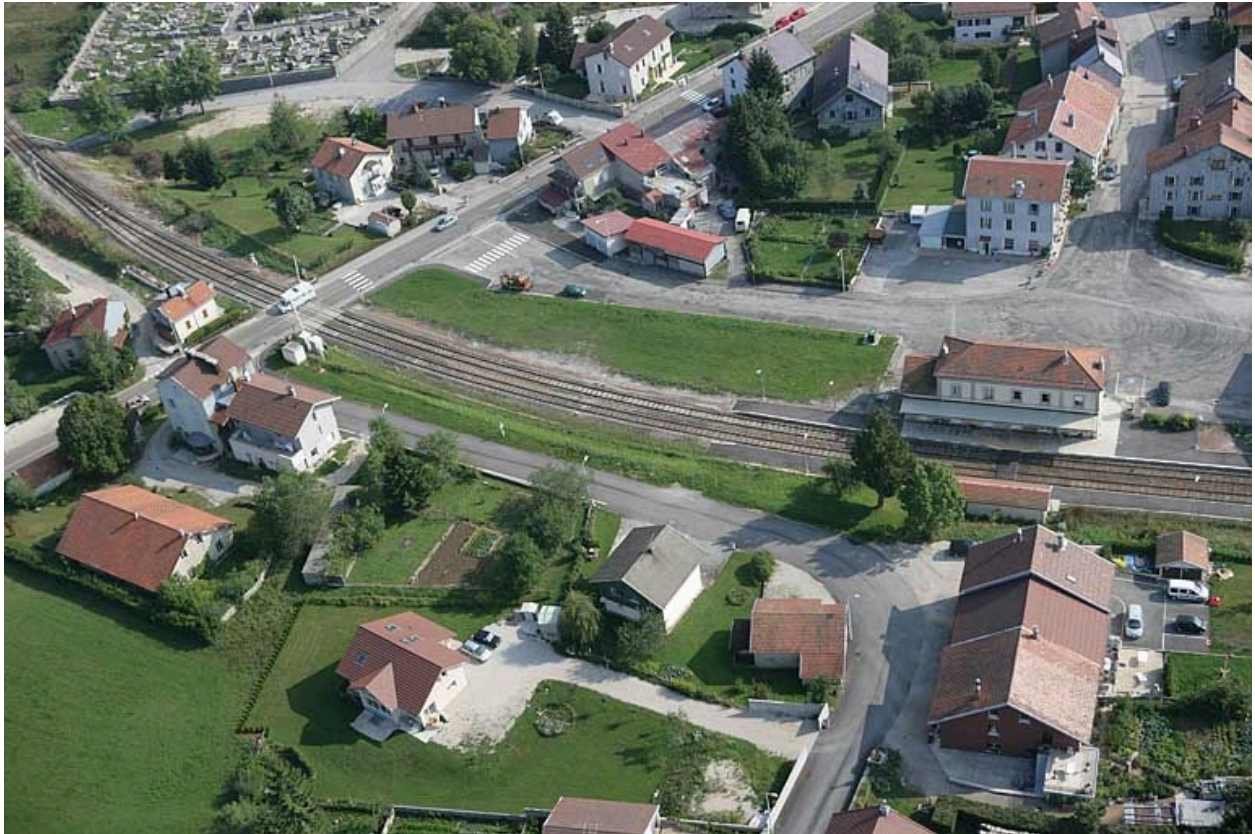
Vue aérienne, depuis l'ouest.
