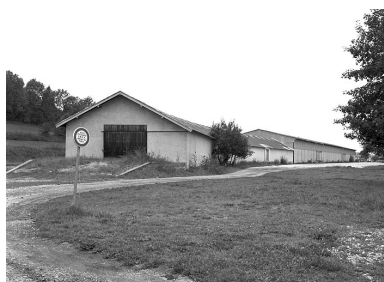
Entrepôts, depuis le sud-est.
