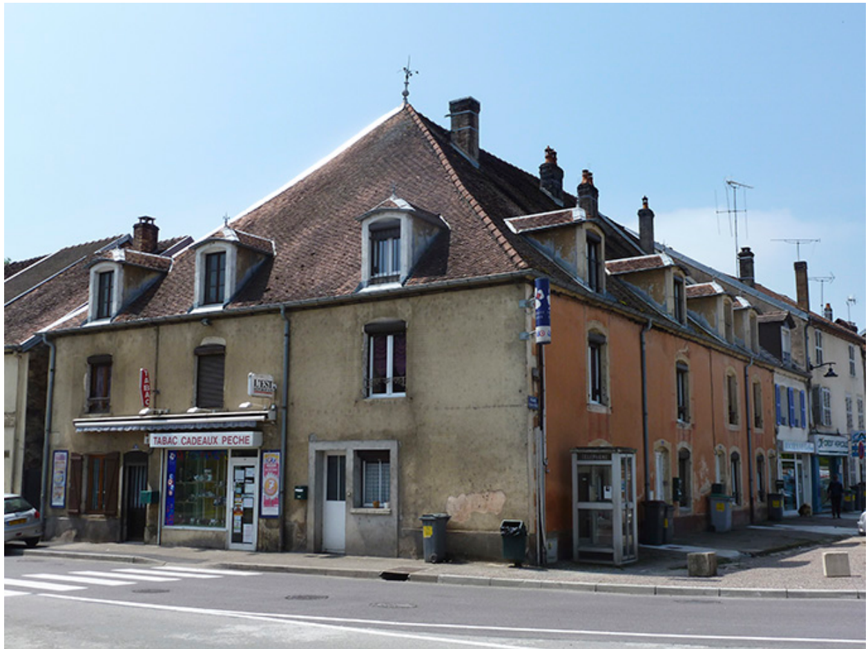
Façade sur la rue du Général Détrie.
