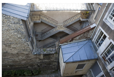
Vue d'ensemble de l'escalier à cage ouverte depuis la parcelle voisine.
