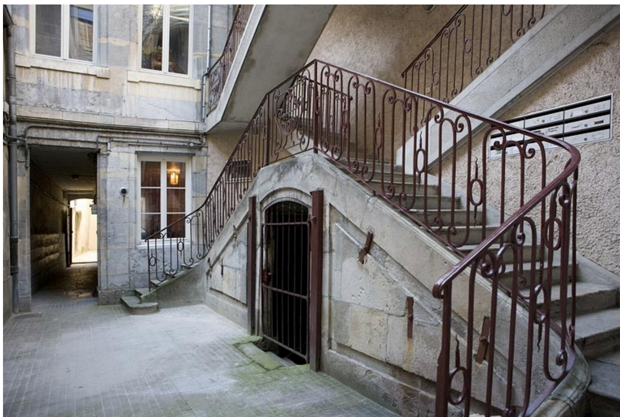
Vue d'ensemble du départ de l'escalier à cage ouverte sur cour.
