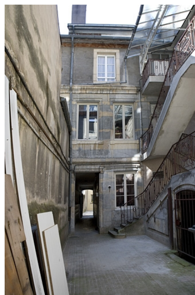
Vue d'ensemble de la façade antérieure du premier logis secondaire.
