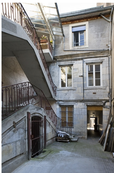
Vue d'ensemble de la façade postérieure du logis principal et de l'escalier à cage ouverte.
