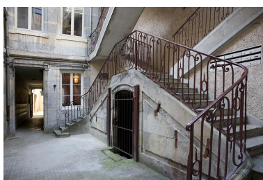
Vue d'ensemble du départ de l'escalier à cage ouverte sur cour.
