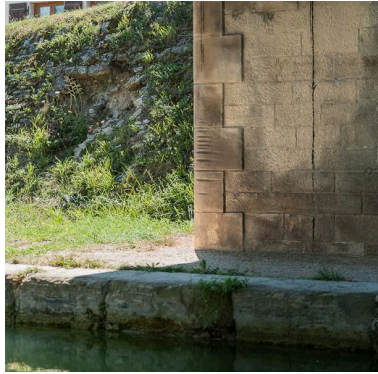
Détail des marques de halage sur la pile du pont.
