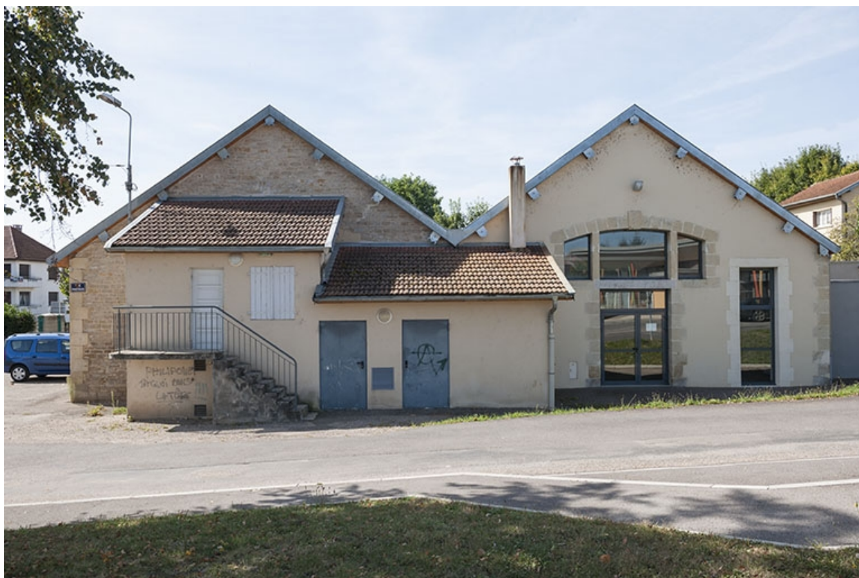
Vue d'ensemble des deux anciennes écuries.
