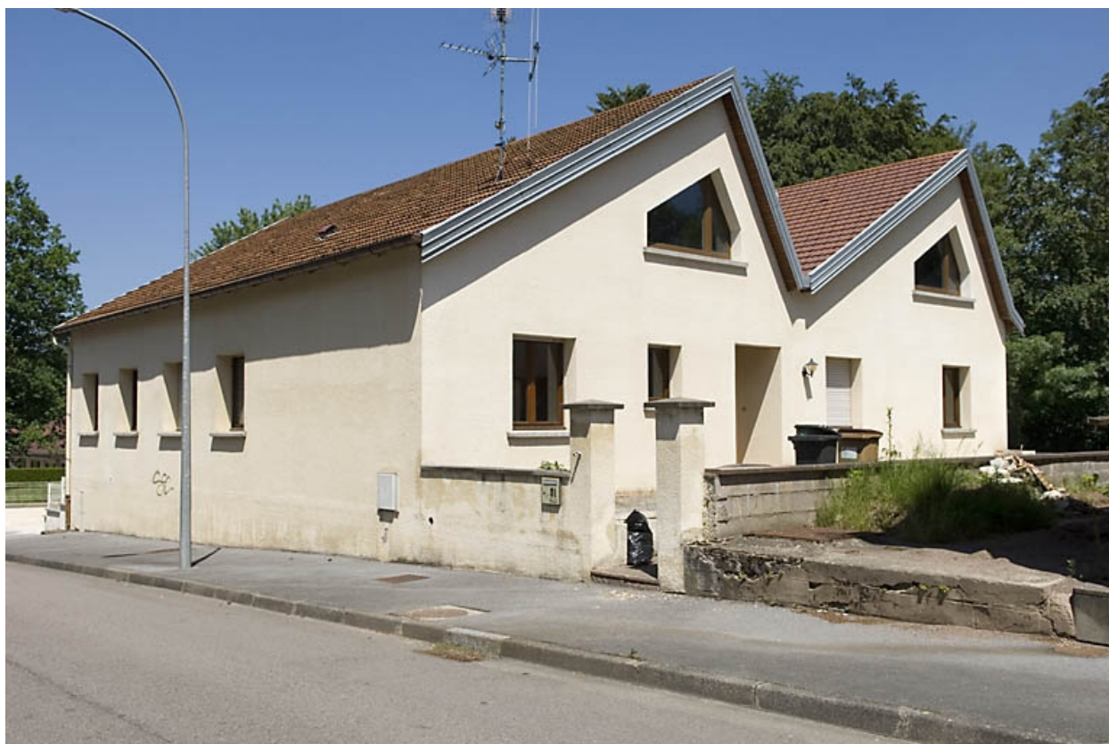
Ancien atelier de fabrication (polissage).
