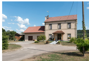
Façade antérieure de l'ancienne gare. Phot. Sonia Dourlot IVR43_20187000517NUC4A
