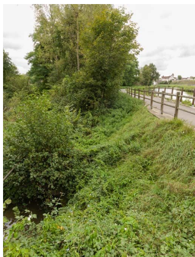
Vue de l'aqueduc. Phot. Pierre-Marie Barbe-Richaud IVR26_20177100350NUC2A
