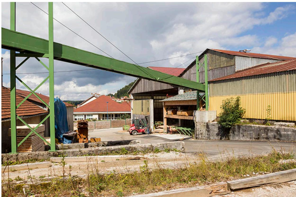
Ateliers de triage et d'empilage (G, F, E), de trois quarts droite. Le tapis roulant d'amenée de la sicure et des copeaux enjambe la voie.
