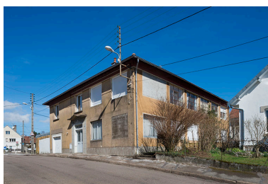
Vue d'ensemble depuis le sud. Phot. Jérôme Mongreville IVR43_20182500560NUC4A
