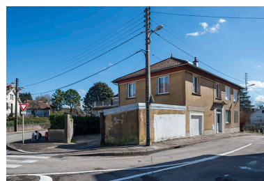
Vue d'ensemble depuis l'ouest. Phot. Jérôme Mongreville IVR43_20182500561NUC4A
