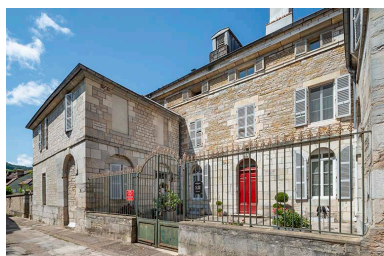
Vue d'ensemble, de trois quarts droite. Phot. Jérôme Mongreville IVR43_20233900721NUC4A
