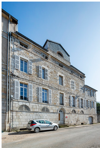
Façade postérieure vue de trois quarts. Phot. Jérôme Mongreville IVR43_20243900541NUC4A
