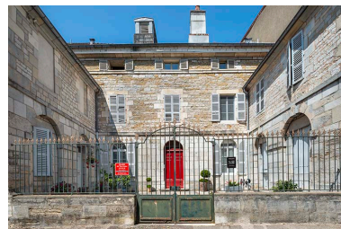
Vue de face depuis la rue d'Orgemont. Phot. Jérôme Mongreville IVR43_20233900720NUC4A
