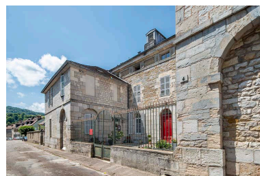
L'aile sud et la cour. Phot. Jérôme Mongreville IVR43_20233900724NUC4A
