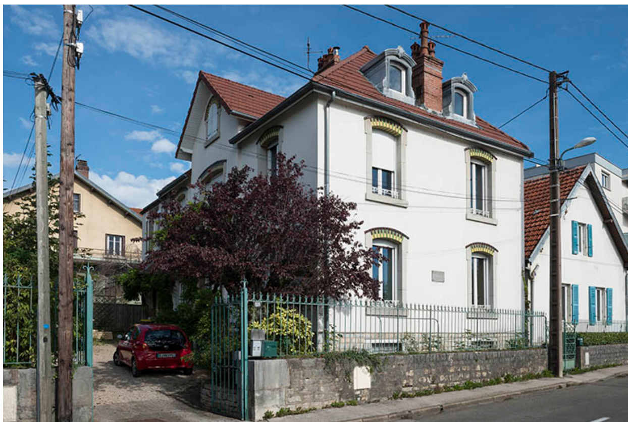
Vue de trois quarts depuis la rue.
