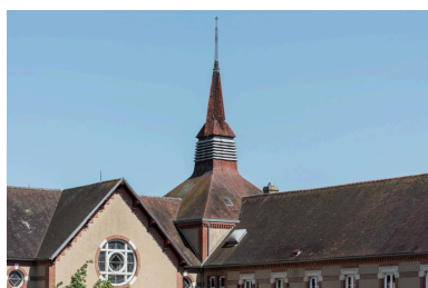
Détail du couvrement de la chapelle et du campanile. Phot. Pierre-Marie Barbe-Richaud IVR26_20238900558NUC4A
