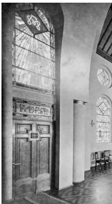
Détail de l'une des baies donnant sur le chœur, entre 1934 et 1944. Phot. Pierre-Marie Barbe- Richaud, Autr. auteur inconnu IVR26_20238900759NUC2A
