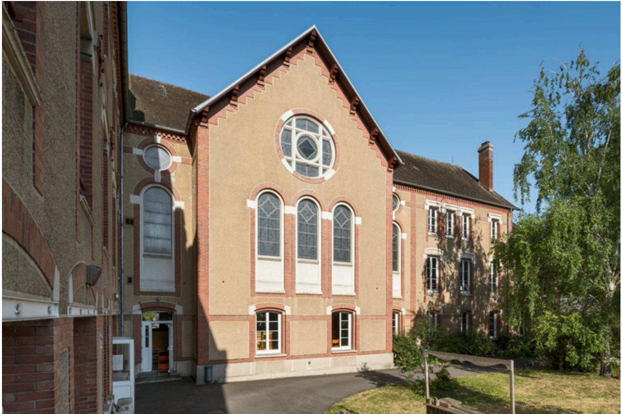
Vue de la façade ouest de l'aile nord : la chapelle.
