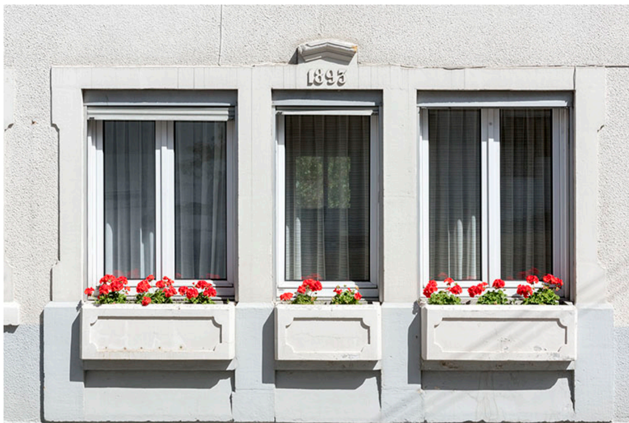
Façade antérieure : linteau daté.
