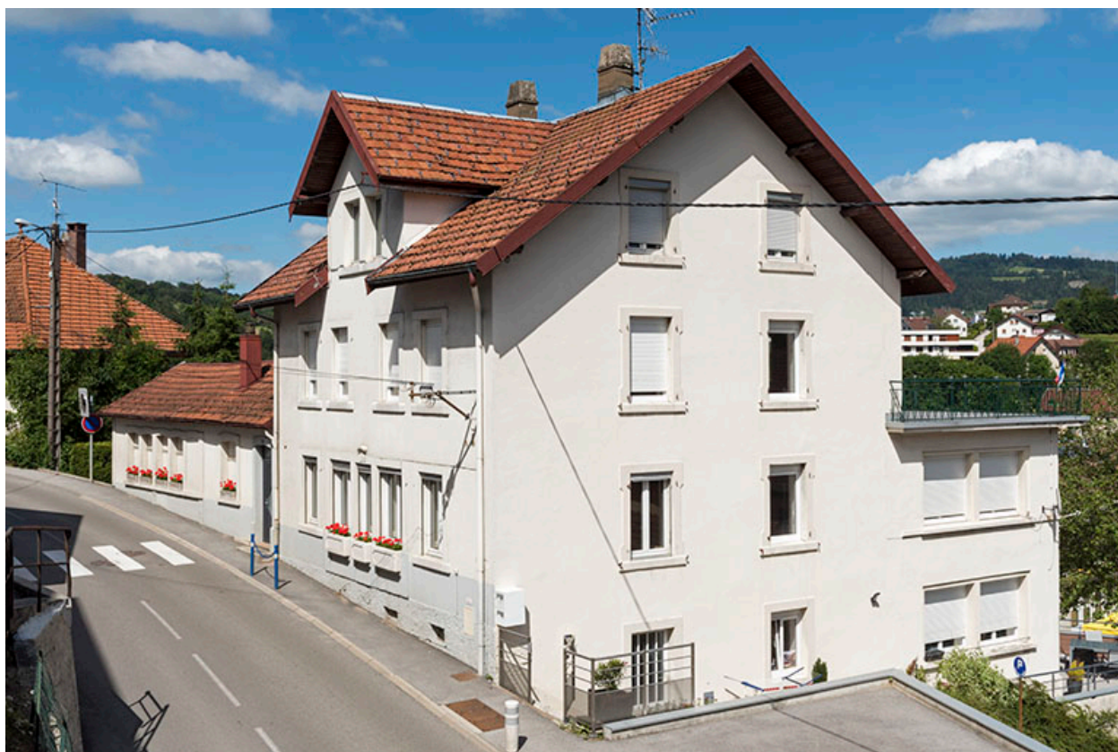
Façades antérieure et latérale droite.
