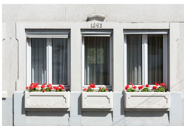
Façade antérieure : linteau daté.
