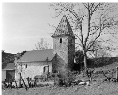
Face nord et tour clocher. Phot. Jérôme Mongreville IVR43_19973900261X
