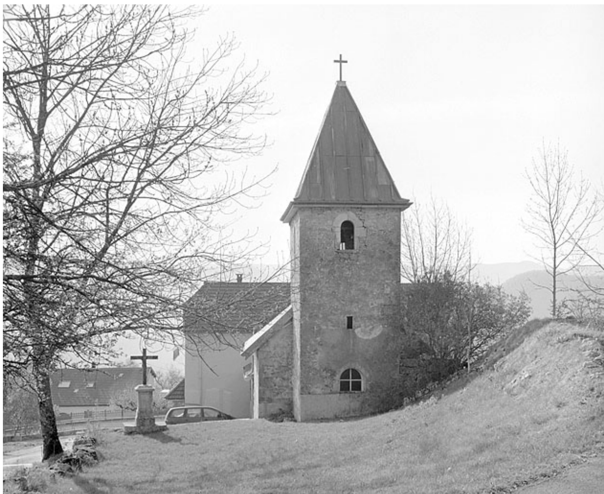
Vue générale depuis l'ouest.
