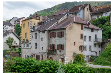
Vue d'ensemble depuis le sud- ouest (immeuble à gauche). Phot. Jérôme Mongreville IVR43_20233900453NUC4A
