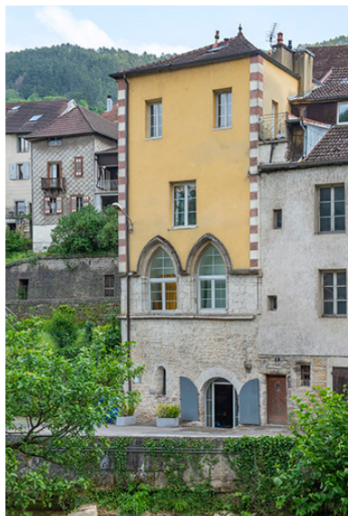
Élévation de la façade ouest. Phot. Jérôme Mongreville IVR43_20233900461NUC4A
