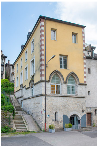
Vue depuis le nord-ouest. Phot. Jérôme Mongreville IVR43_20233900462NUC4A
