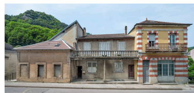
Elévation de la façade rue Gambetta (maison de droite). Phot. Jérôme Mongreville IVR43_20233900669NUC4A
