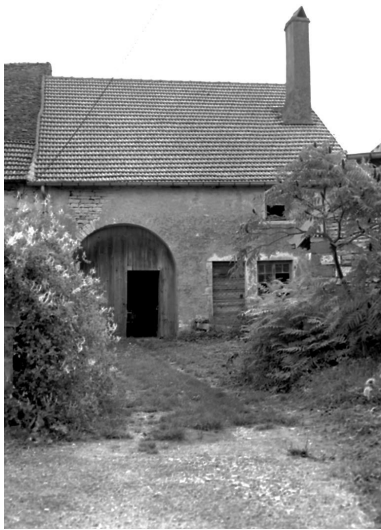
Façade antérieure. Phot. Dominique Dominguez IVR43_19807000393X
