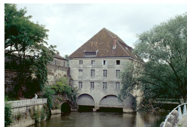
Ancien moulin vu de l'aval. Phot. Laurent Poupard IVR43_19893900255ZA
