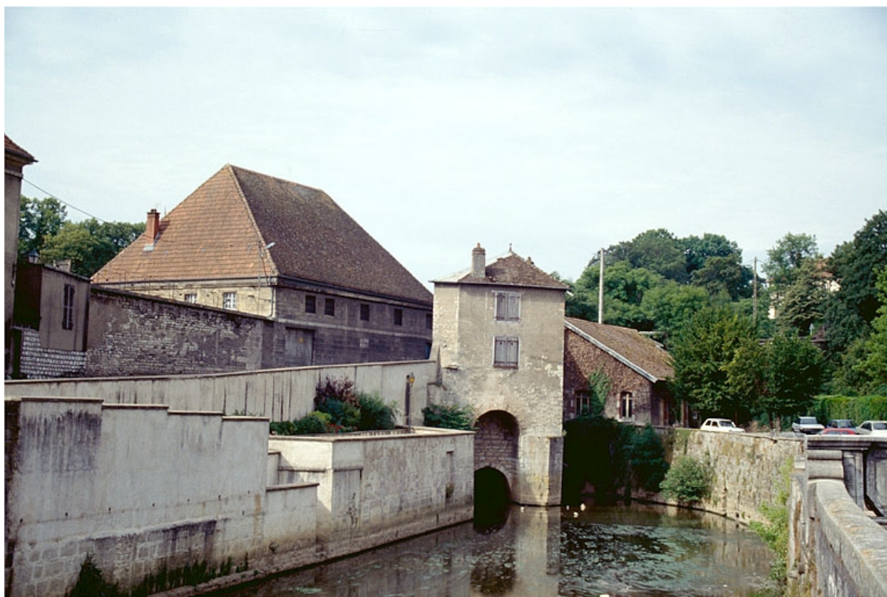
Bureau (ancienne tour de fortification).
