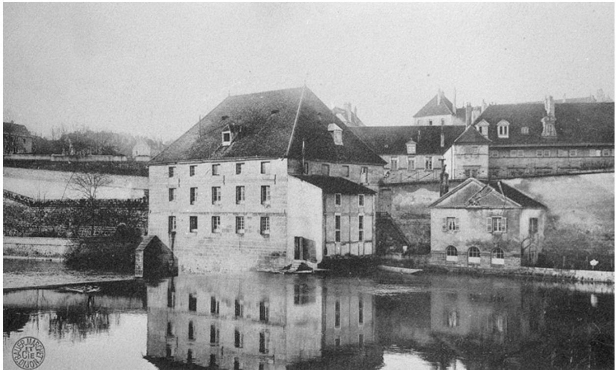
Dole - Ancien Moulin - Machine élévatoire.
