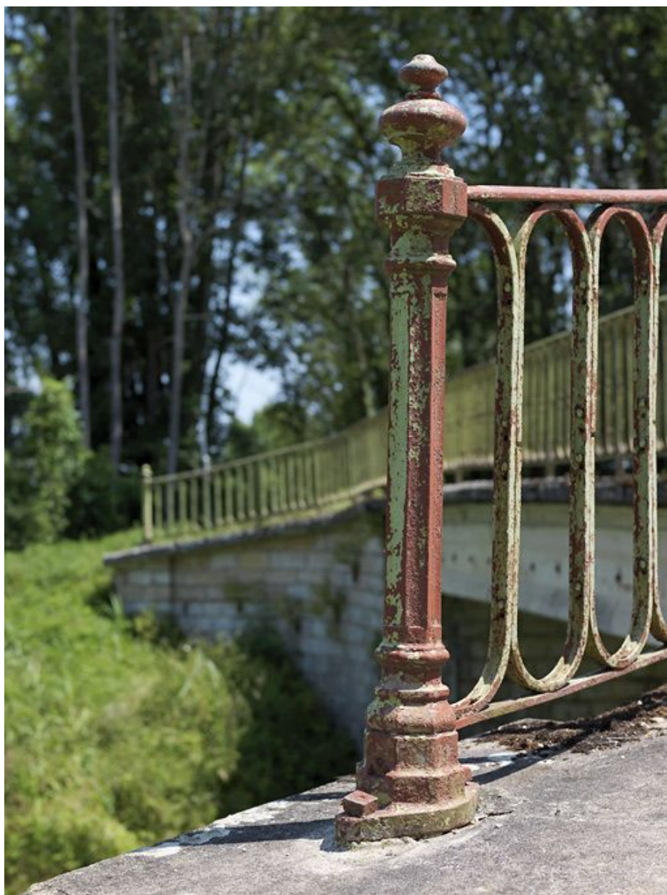
Détail du garde-corps en métal.
