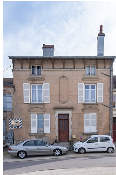
Façade sur rue. Phot. Jérôme Mongreville IVR43_20227000032NUC4A
