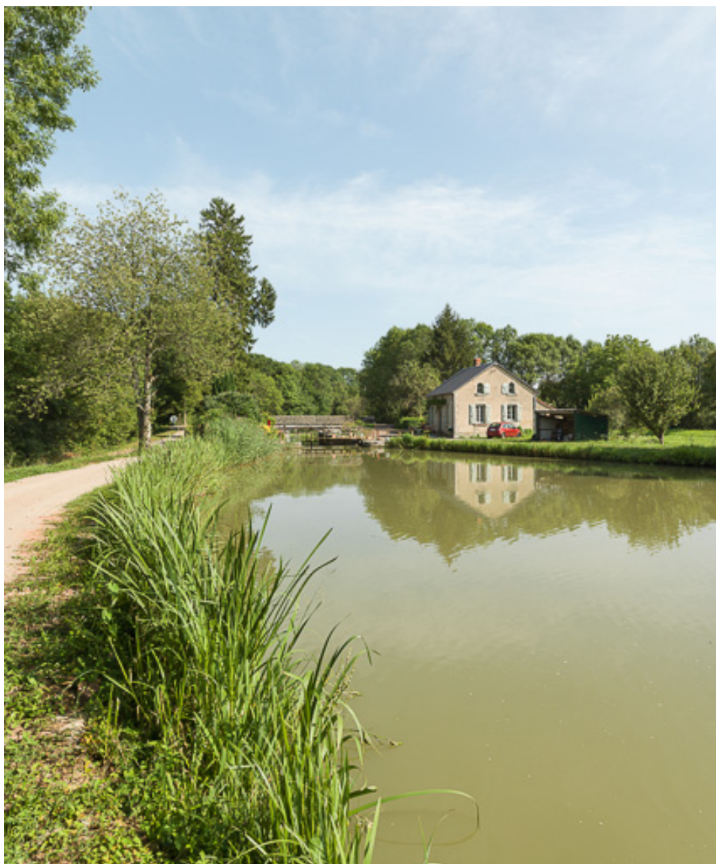
Vue d'ensemble du site d'écluse.
