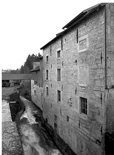
Façade sur le ruisseau de la Raillette. Phot. Jérôme Mongreville IVR43_19963900065V
