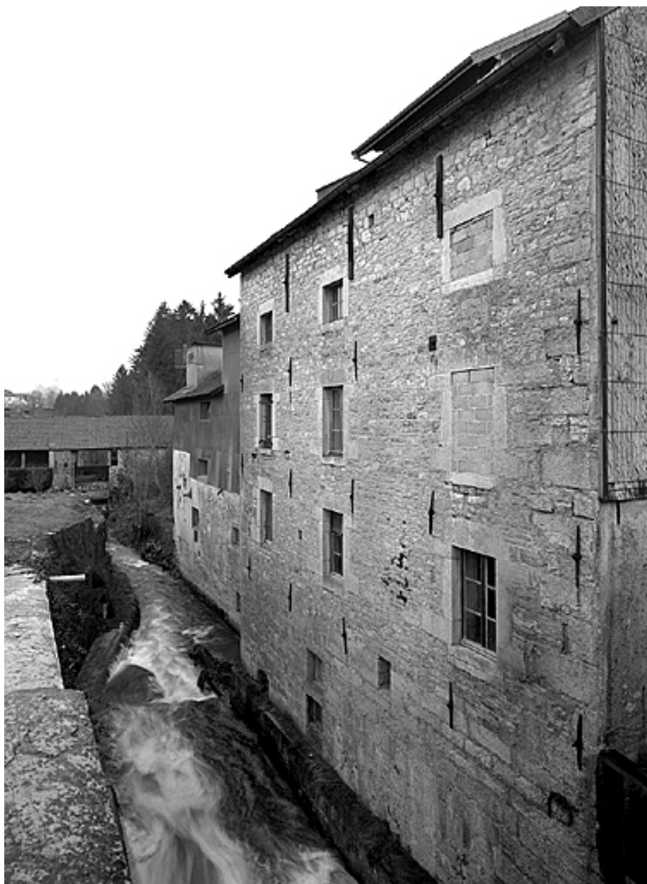
Façade sur le ruisseau de la Raillette.
