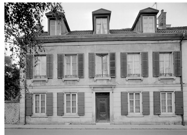
Façade sur rue. Phot. Jérôme Mongreville IVR43_19872501141V
